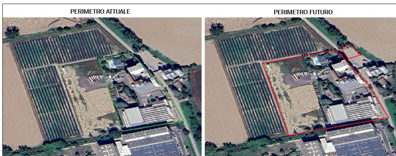
Figura 1: Perimetro attuale e futuro di stabilimento – Fonte: Google Earth
