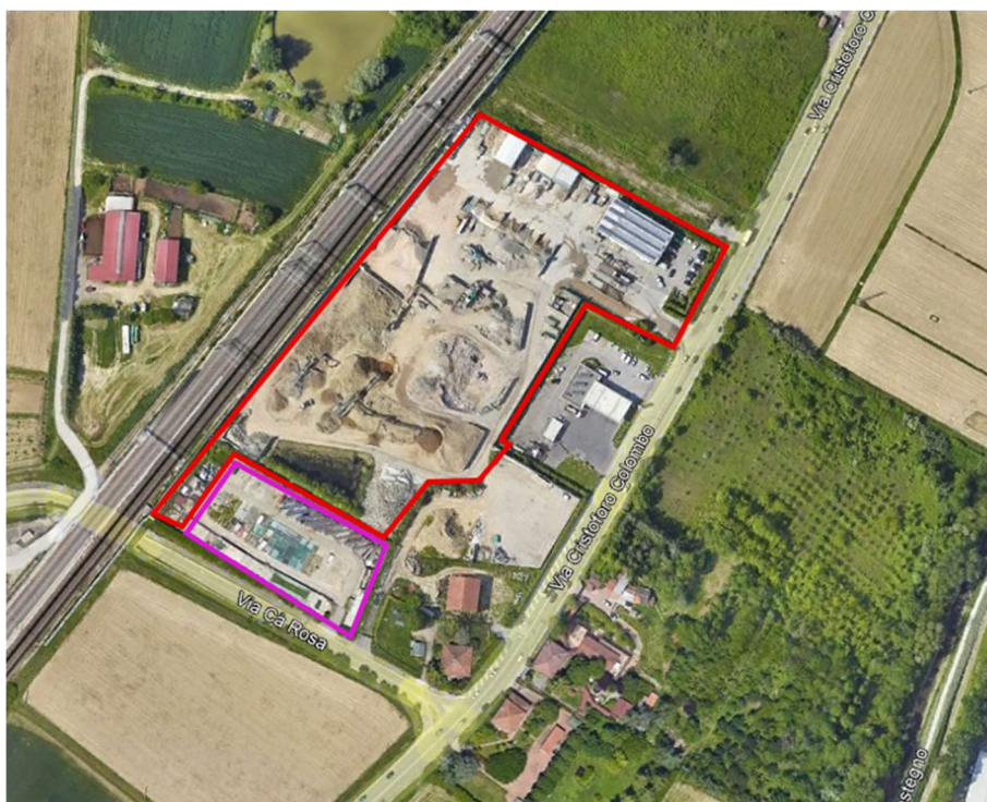
Fig. 3.2 – Individuazione area impianto autorizzato (in rosso) e zona 2 – lavorazione terre EoW (in fucsia)
