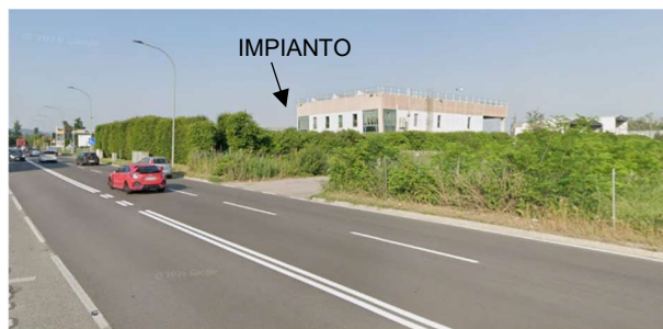
Fig. 6.25 – Vista impianto da via C. Colombo
