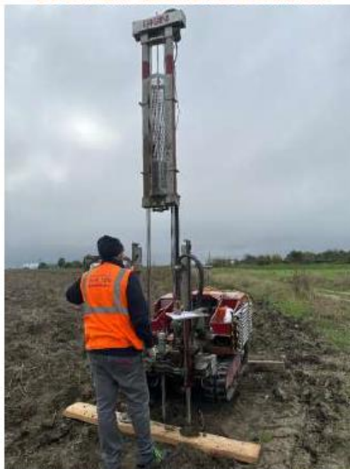
Figura 25 – Particolare prova dpsh
