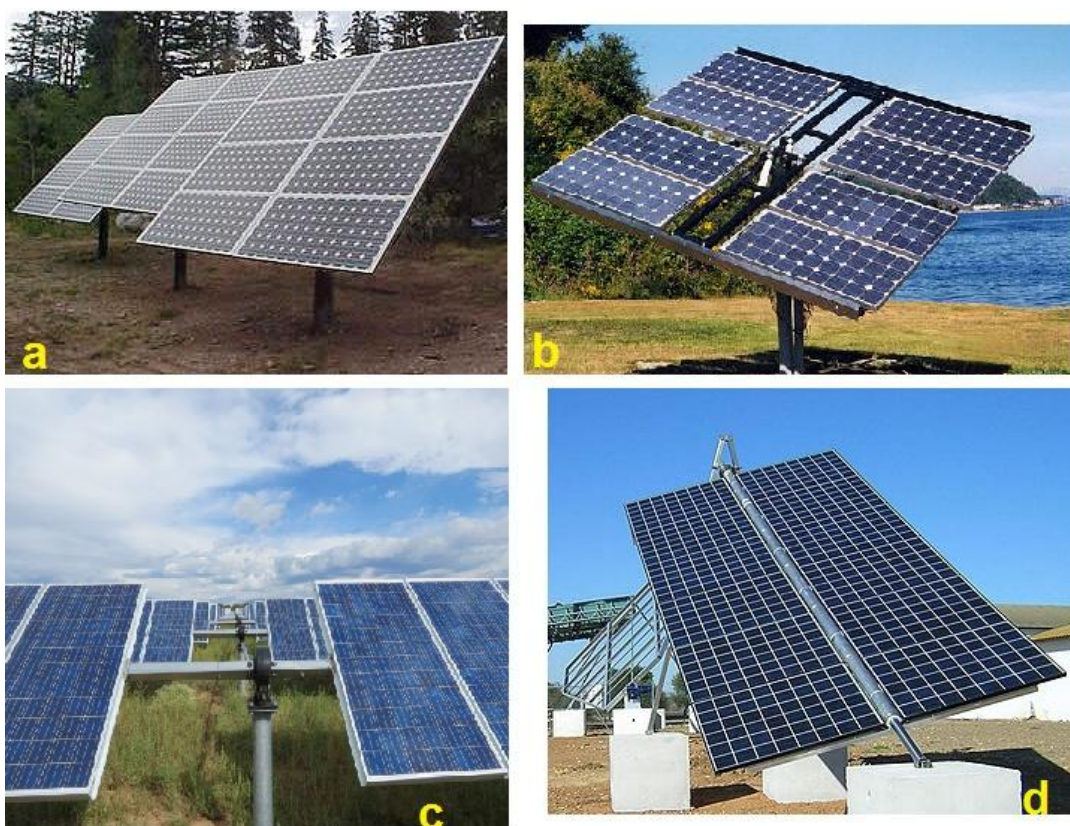
Figura 40 - Sistemi ad inseguimento: a) inseguitore di tilt, b) inseguitore di azimut, c) inseguitore di rollio, d) inseguitore ad asse polare.
