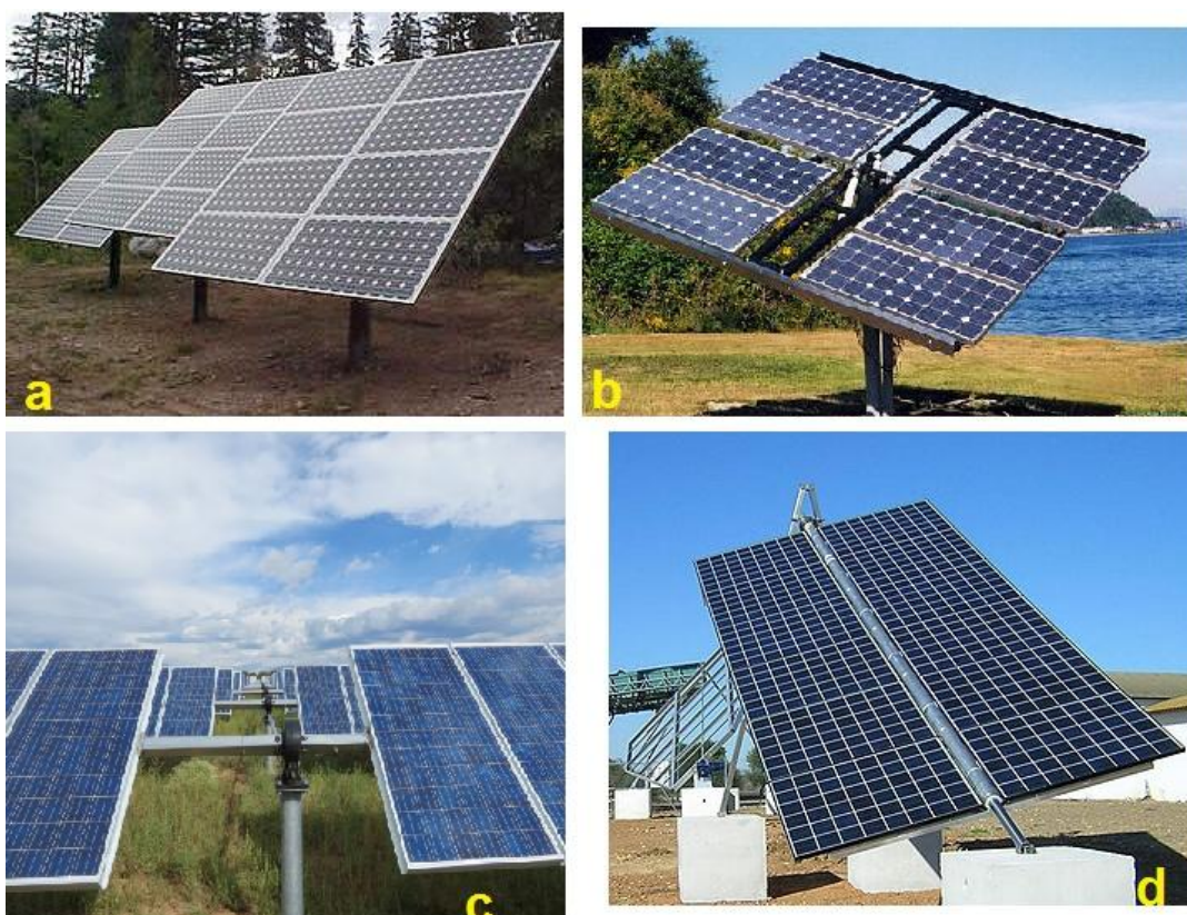
Figura 42 - Sistemi ad inseguimento: a) inseguitore di tilt, b) inseguitore di azimut, c) inseguitore di rollio, d) inseguitore ad asse polare.
