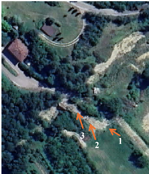
Foto 4: Vista dall'alto della frana con posizione delle foto
