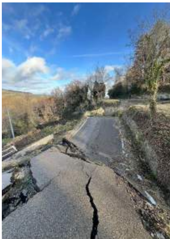
Foto 2,3: Traccia della strada staccata dalla posizione originaria
