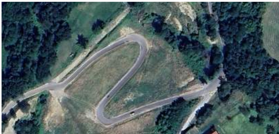
Figura 18: Pianta della bretella realizzata in somma urgenza dall'Esercito Italiano per consentire il superamento della frana che ha coinvolto il tratto stradale e il ponte.
