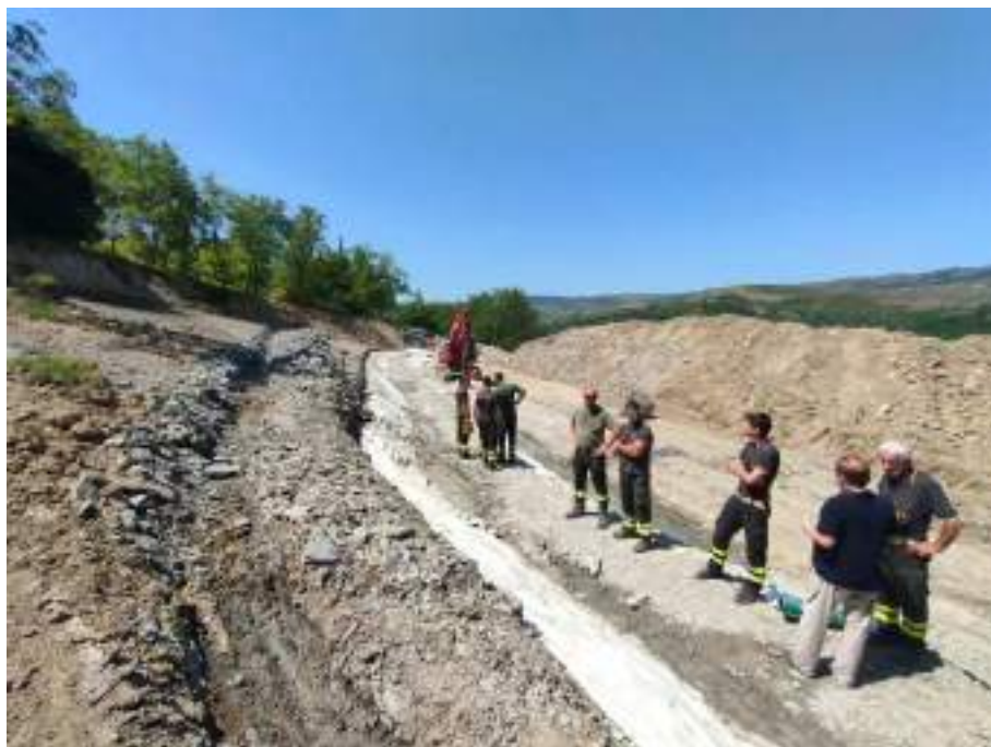
Foto 8: Fase di costruzione della strada: esecuzione dei drenaggi al piede della scarpata di monte
