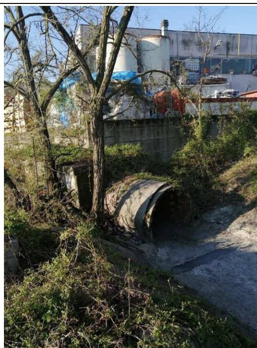
Foto 2 – Vista della parte terminale del tombamento del Fosso Fontanile nella zona a valle dell'intersezione con Via Viazza, oltre i capannoni industriali. Il fosso scorre entro una condotta di diametro 1500 mm per poi tornare a scorrere a cielo aperto sino alla confluenza nel Torrente Taglio.
