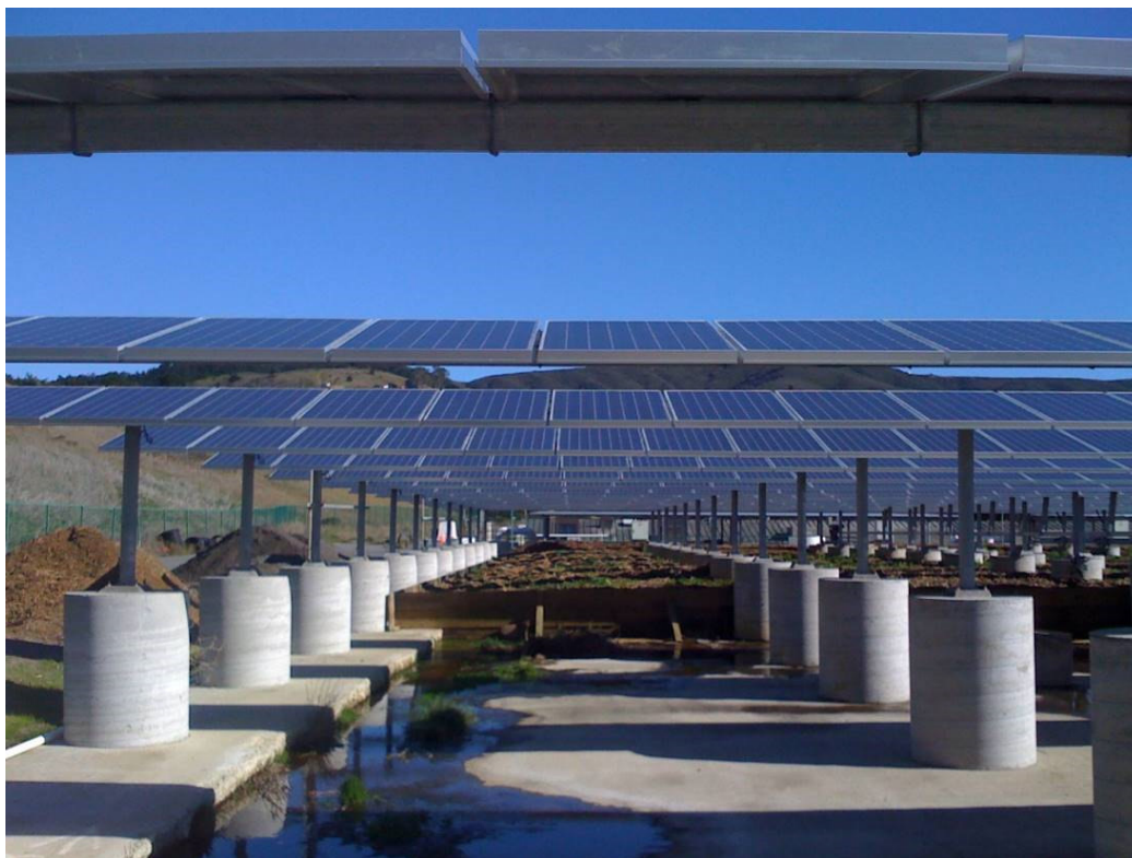
Figura 8.1.5 – Esempio di impianto fotovoltaico con fondazioni formate da zavorre costituite da plinti in cemento.
