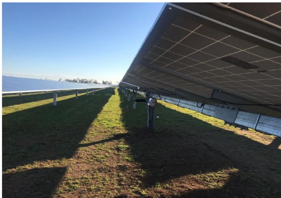
Figura 8.1.2 – Esempio di impianto fotovoltaico realizzato con supporti costituiti da pali in acciaio infissi direttamente nel terreno. Gli impatti sul suolo sottostante risultano essere minimizzati.
