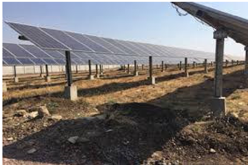
Figura 8.1.4 – Esempio di impianto fotovoltaico con fondazioni ottenute mediante perforazione del terreno e successiva creazione del palo di fondazione con getto di cemento.
