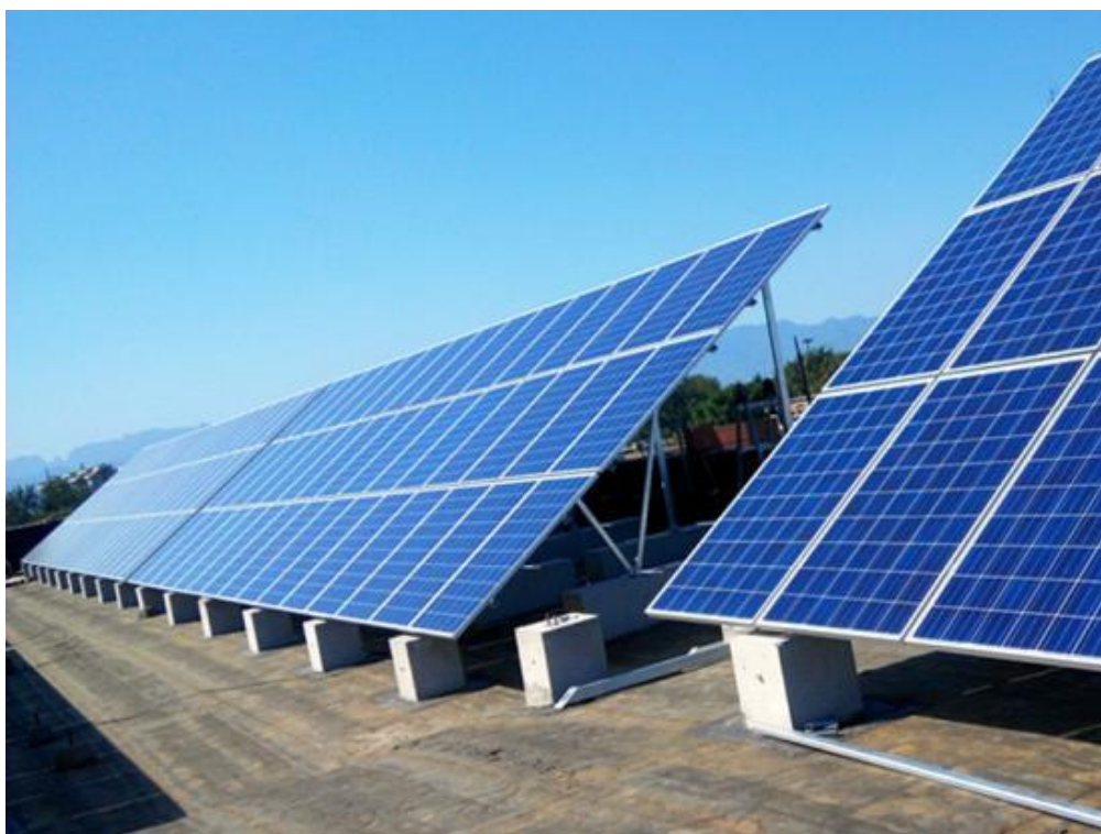
Figura 8.1.6 – Esempio di impianto fotovoltaico con fondazioni formate da zavorre costituite da plinti in cemento.
