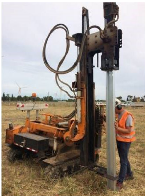
Figura 8.1.1 – Esempio di supporto costituito da palo in acciaio infisso direttamente nel terreno mediante battipalo.
