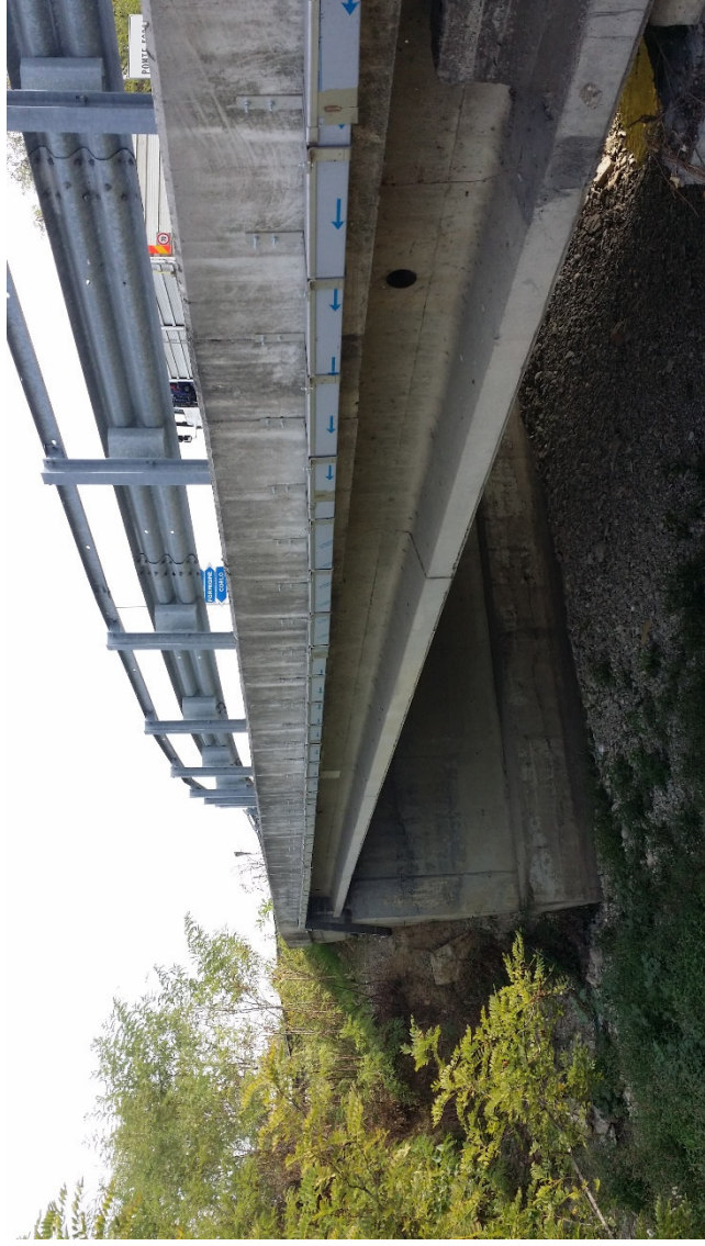
Figura 8.3.4 – Esempio tipologico di canalina staffata presso la struttura di un viadotto stradale.
