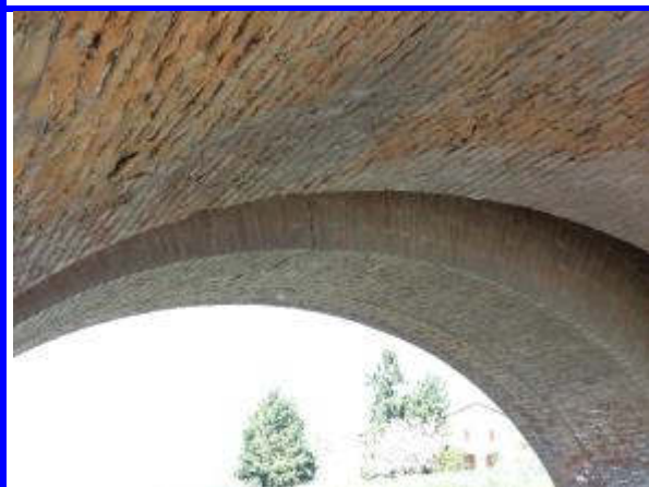
Lesione in chiavearco sotto edificio chiuse
