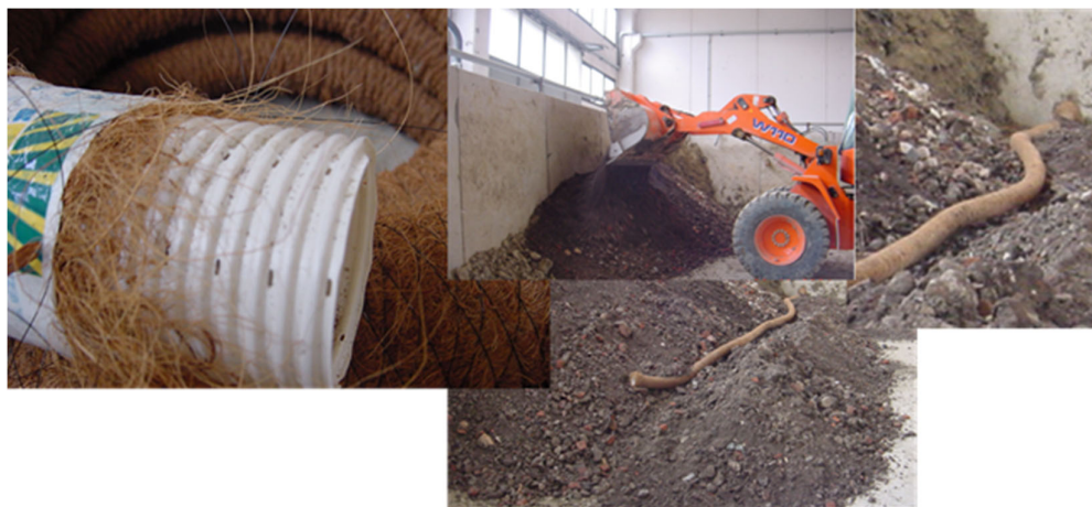
Figura 5.2 – Fasi di preparazione di una biopila
