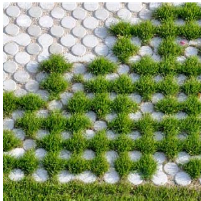
Fig.51.: Tipologico pavimentazioni in green realizzata con cubetti in calcestruzzo
