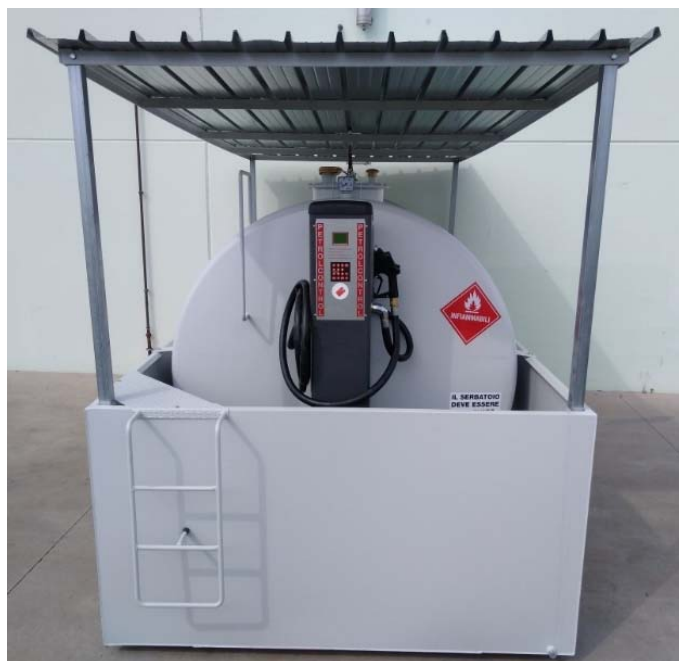
Fig.14.: Serbatoio carburante con colonnina di distribuzione, vasca per il contenimento di eventuali sversamenti e tettoia metallica di copertura
