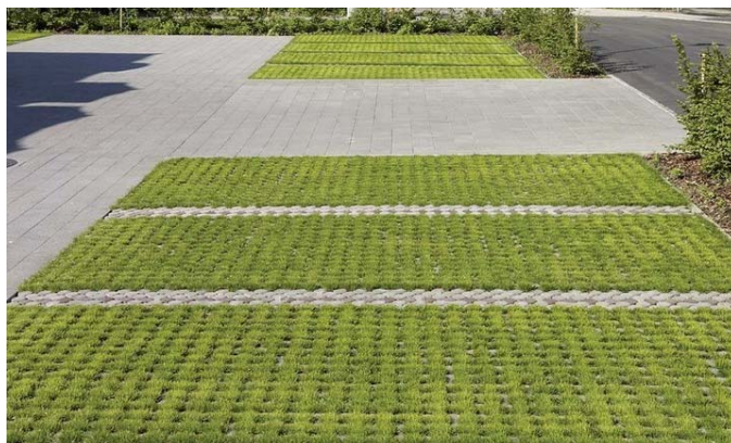
Fig.51.: Tipologico pavimentazioni in green realizzata con cubetti in calcestruzzo
