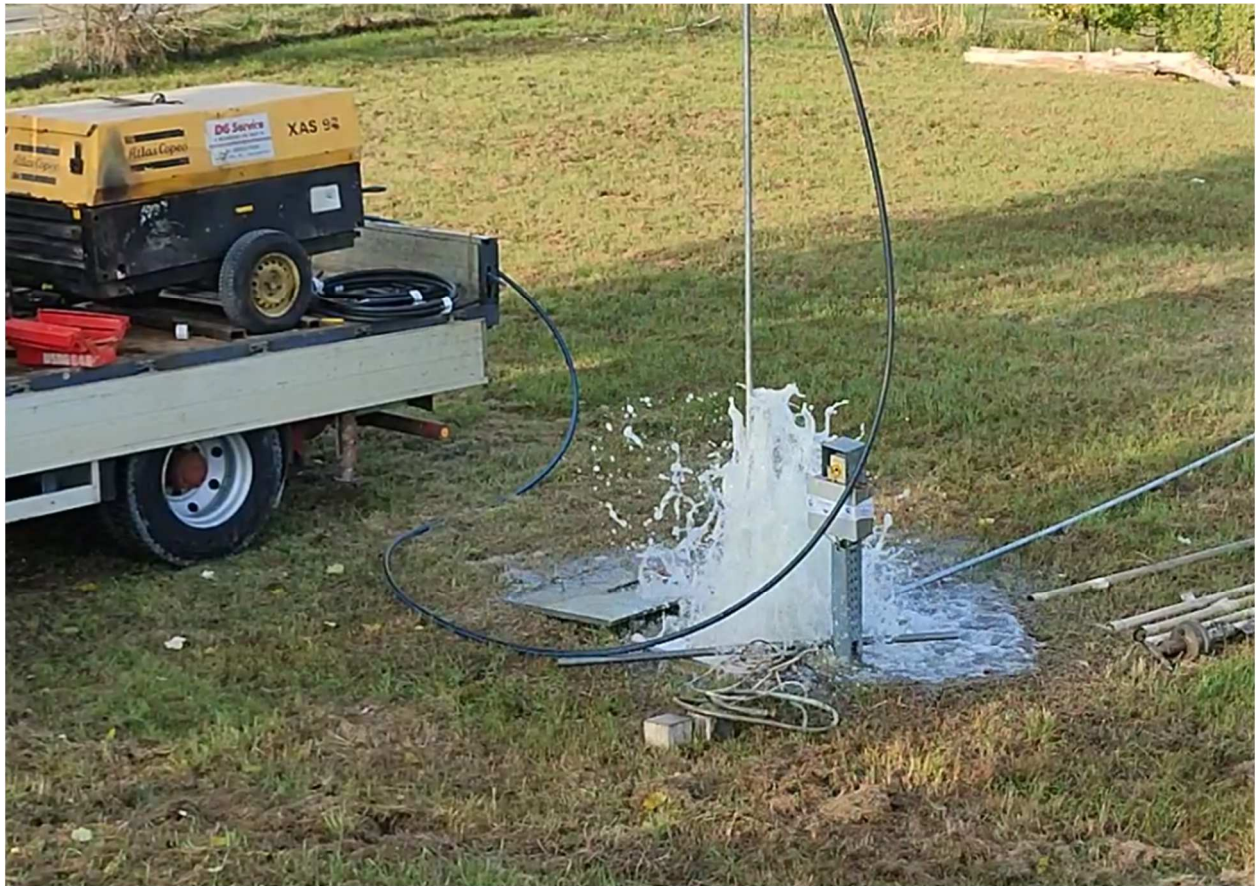
Fig. 2 – operazioni di spurgo del pozzo
