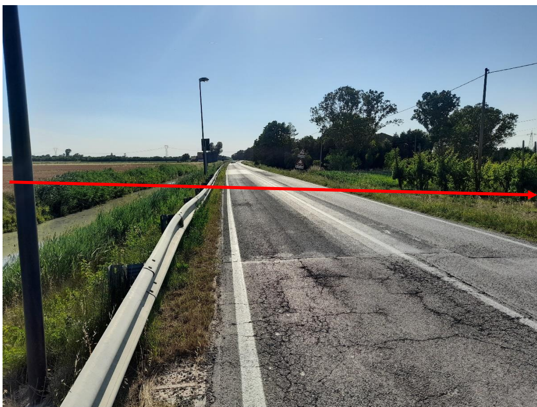
Figura 3.1: Attraversamento Scolo “Canala” e S.P. N. 97, senso gas (in rosso l’andamento qualitativo della tubazione in TOC)
