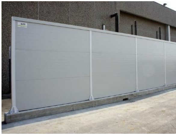
Esempio recinzione con pannelli acustici su plinti o cordolo di fondazione
