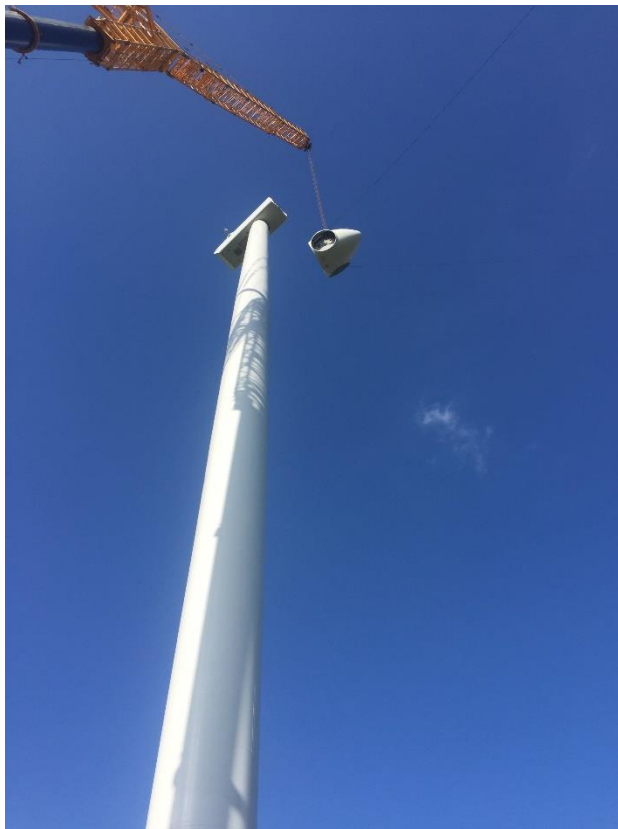
Fig. 15 : montaggio supporto rotore (hub)
