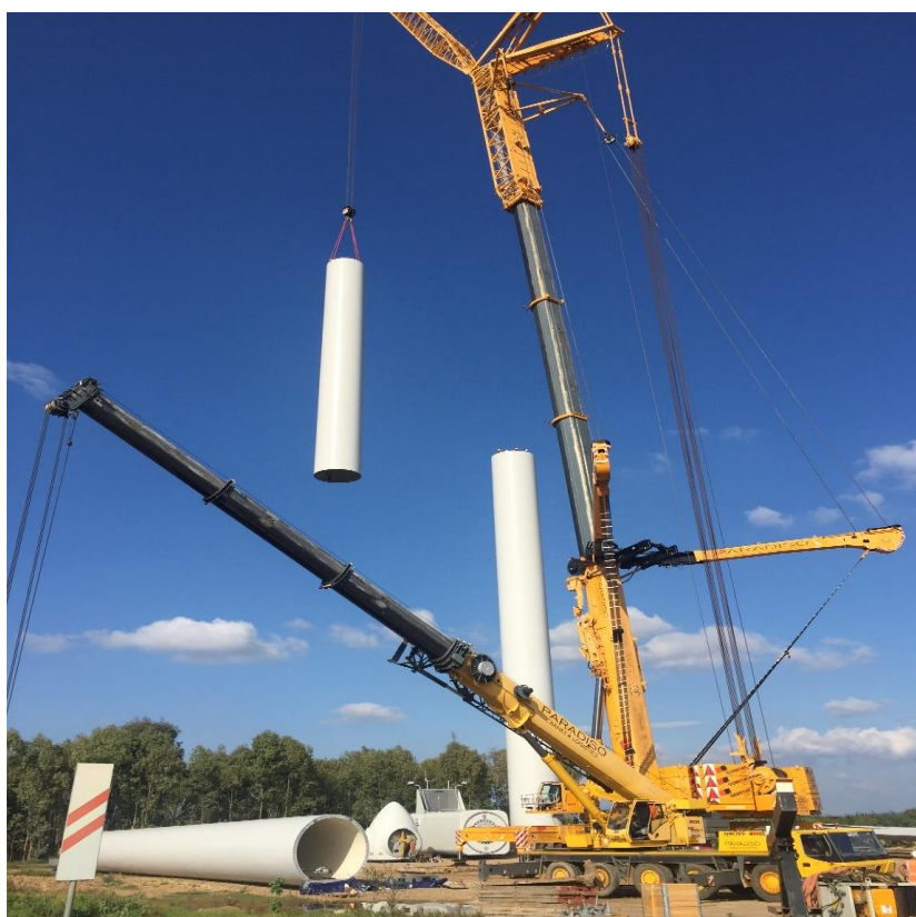
Fig. 14 : montaggio tronco di torre intermedio
