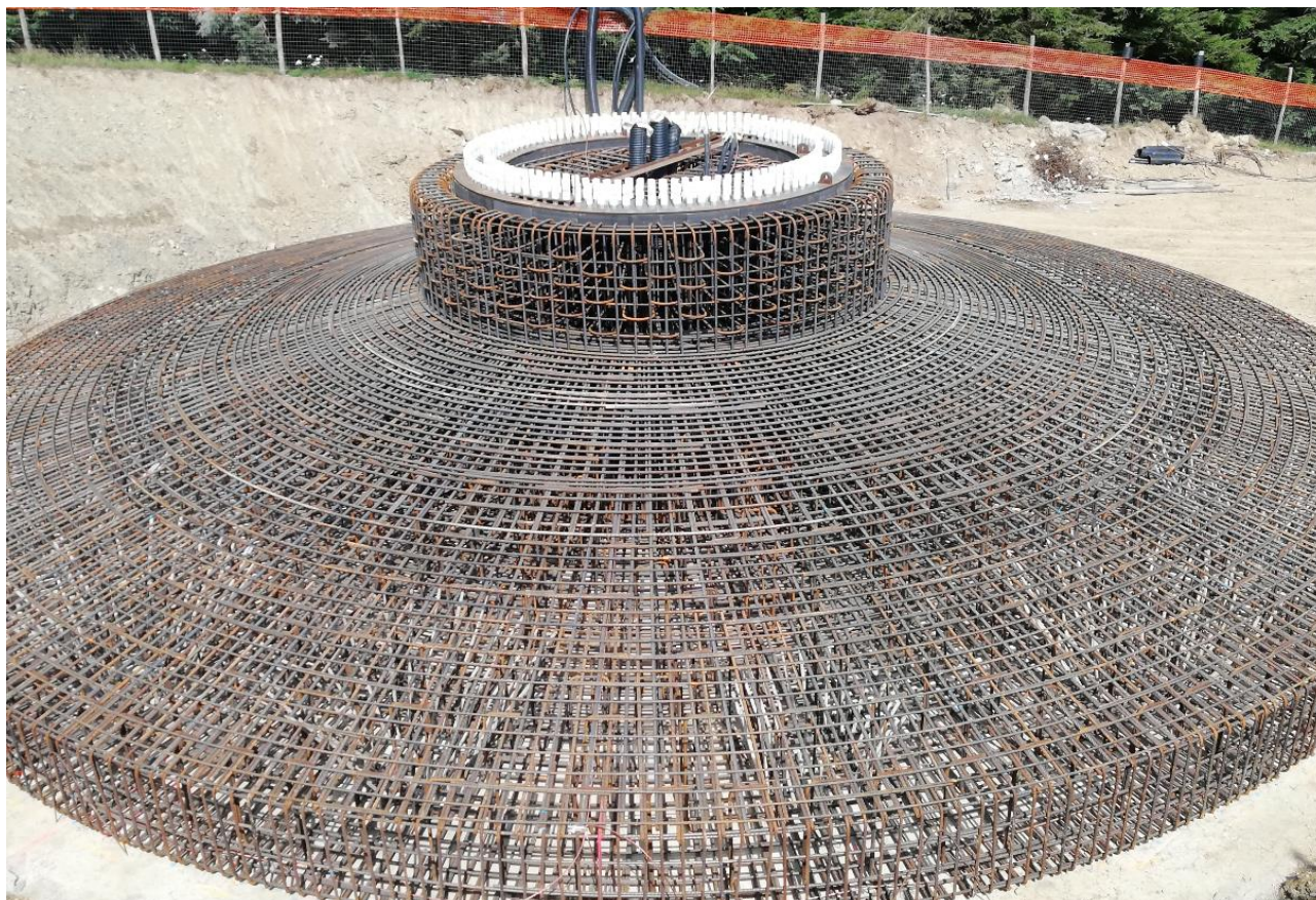
Fig. 20 : armatura plinto su pali parco “Cento Croci”
