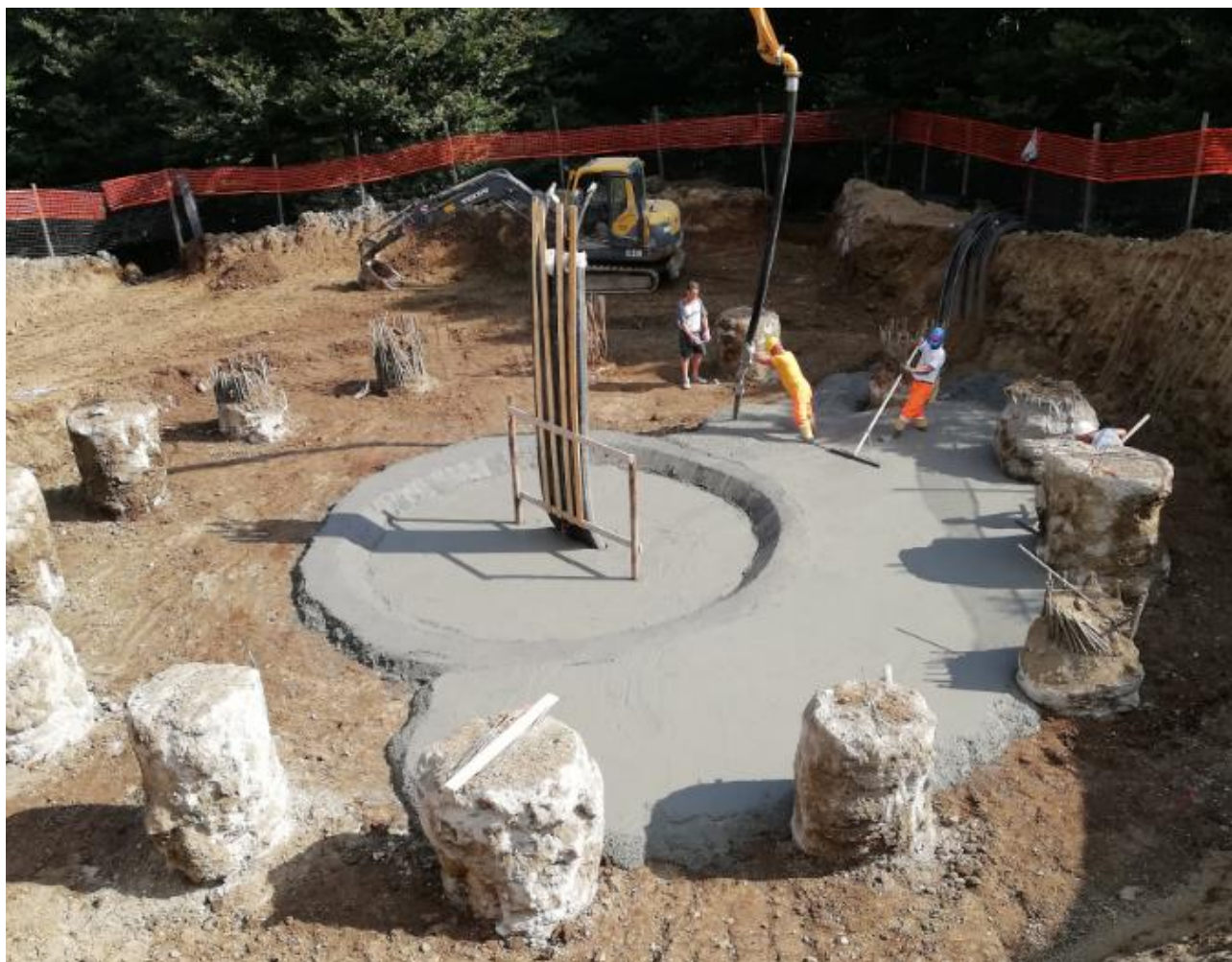
Fig. 19 : Pali di fondazione e preparazione magrone di base Parco “Cento Croci”
