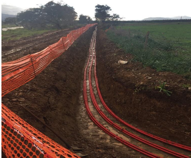
Fig. 22 : posa cavidotti parco del Medio Campidano
