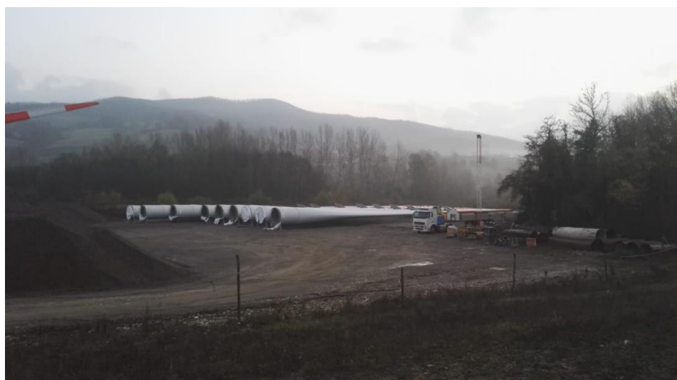
Fig. 10 : stoccaggio temporaneo pale nell'area di trasbordo
