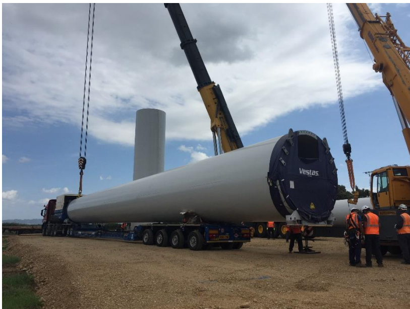
Fig. 11: scarico di tronco di torre
