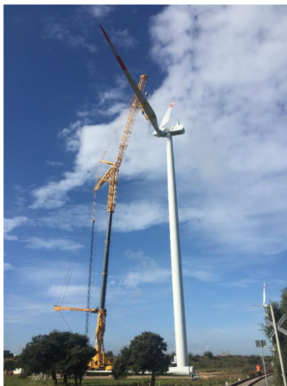
Fig. 16 : montaggio pale
