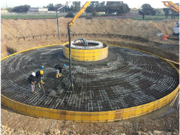
FASE DI REALIZZAZIONE PLINTO IN C.A. CON DEPOSITO TEMPORANEO MATERIALE A BORDO SCAVO
