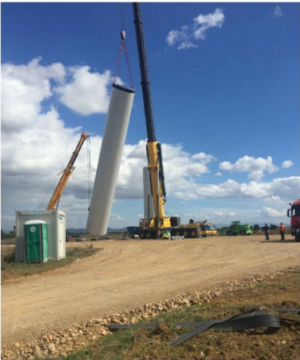
FASE DI ASSEMBLAGGIO PRIMI MONCONI WTG
