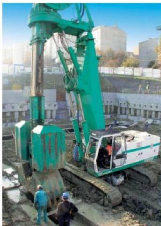
Figura 8 – Perforatrice cingolata tipo Casagrande B180HD
