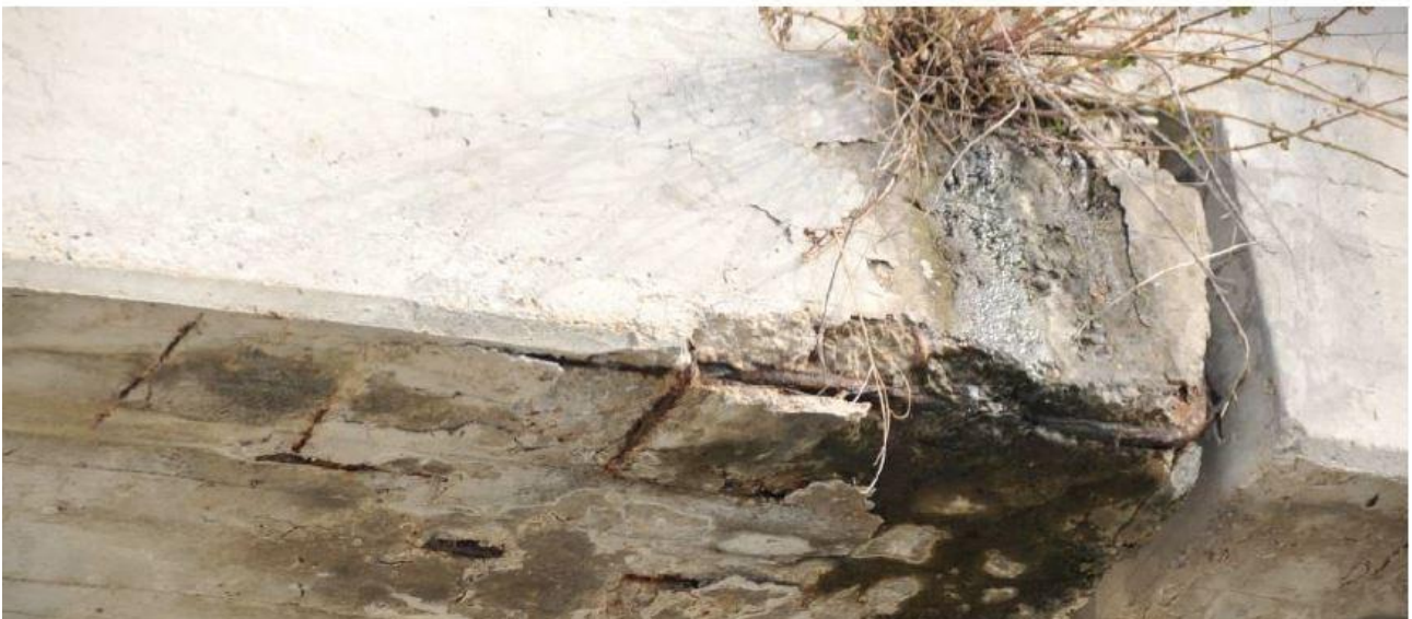
Dettaglio dello stato di degrado del punto di appoggio tra trave e sella Gerber
