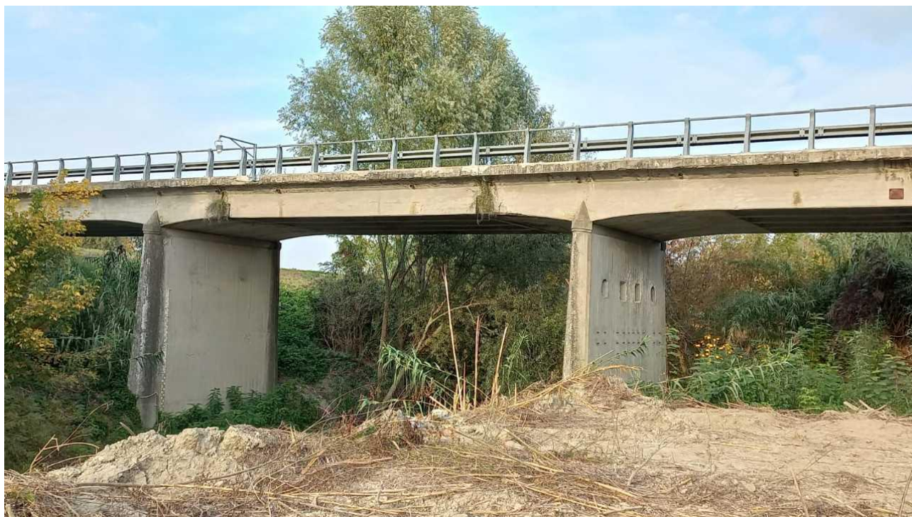
Immagine della campata centrale con trave "Gerber"
