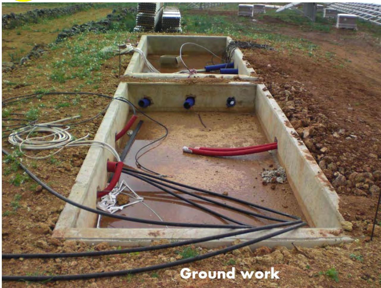
Figura 44 - basamento cabina
