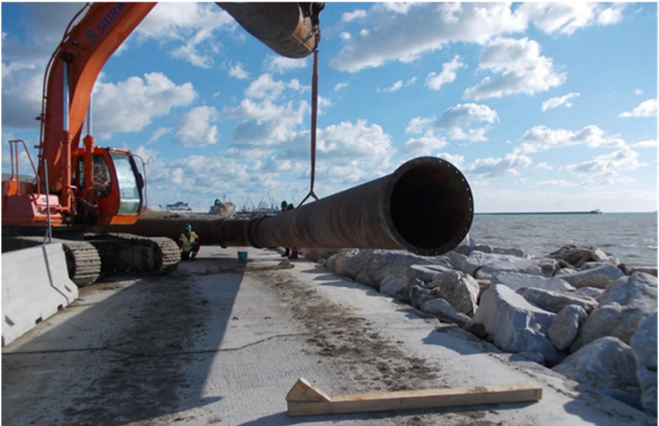
Figura 5 - Esempio di escavatore al lavoro per l'assemblaggio della linea di terra (tubatura rigida)
