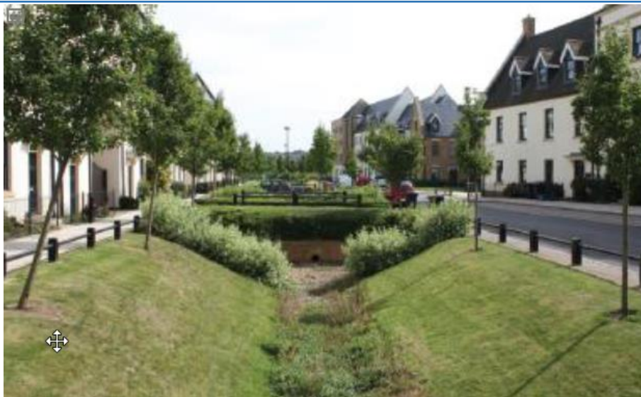
Figura 22: esempio di canale vegetato asciutto
