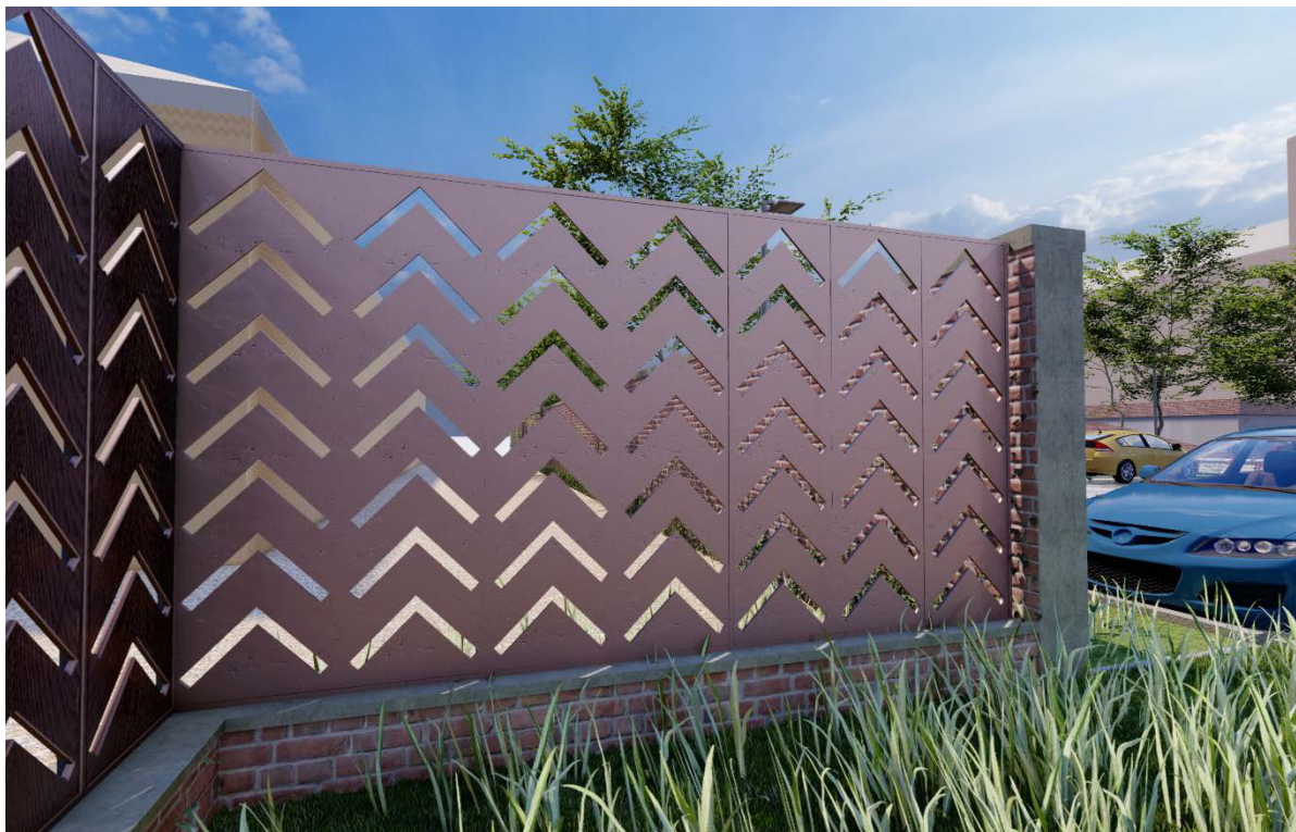
Figura 3.12 - vista della nuova recinzione in pannelli metallici traforati secondo motivo triangolare, su muro in mattoni a faccia in vista
