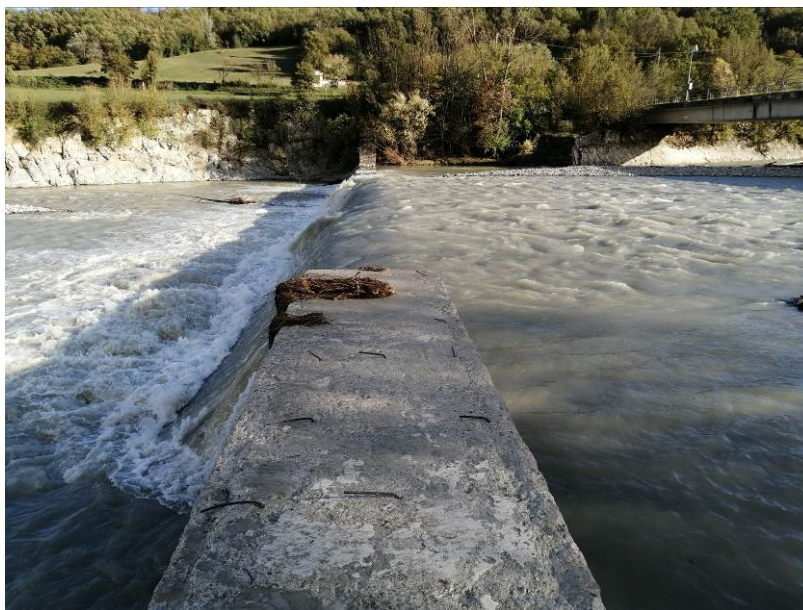
Figura 9 – Tratto di briglia interessato dal ripristino della copertina superficiale
