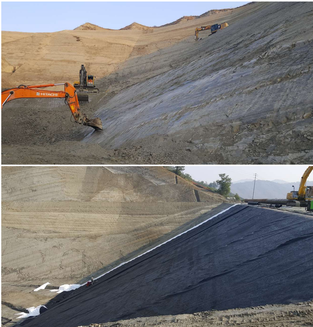
Figura 8 – situazione del versante durante lo sbancamento e dopo il ricoprimento
