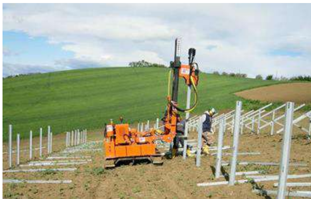
Figura 3.11 – Messa in opera delle strutture di sostegno
