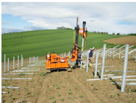
Figura 3: - Posa strutture metalliche di fondazione
