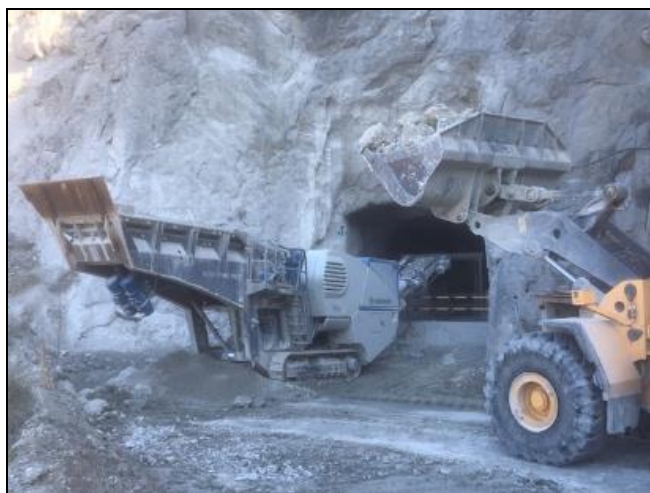
Fig. 17 – Fase di scarico del materiale con pala all'interno del frantoio mobile (sinistra); fase di carico della pietra con escavatore all'interno del dumper.
