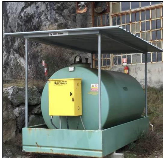
Fig. 12 – Cisterne gasolio: a sinistra presso il piazzale impianti (lt. 3000), a destra sul piazzale di quota 215 m slm (lt. 5000)
