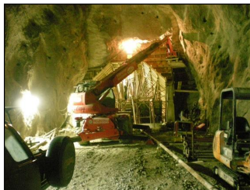
Figura 2-15 Fase di realizzazione della centinatura
