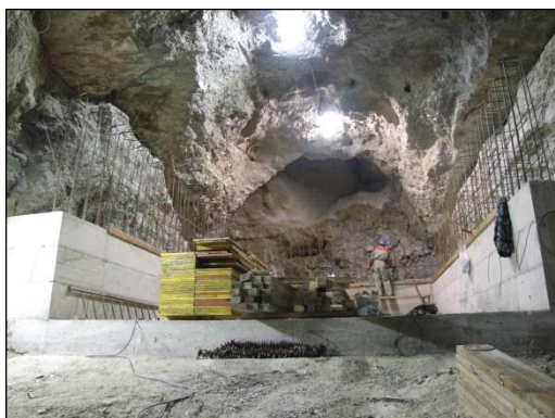
Figura 2-14 Fase di realizzazione della centinatura
