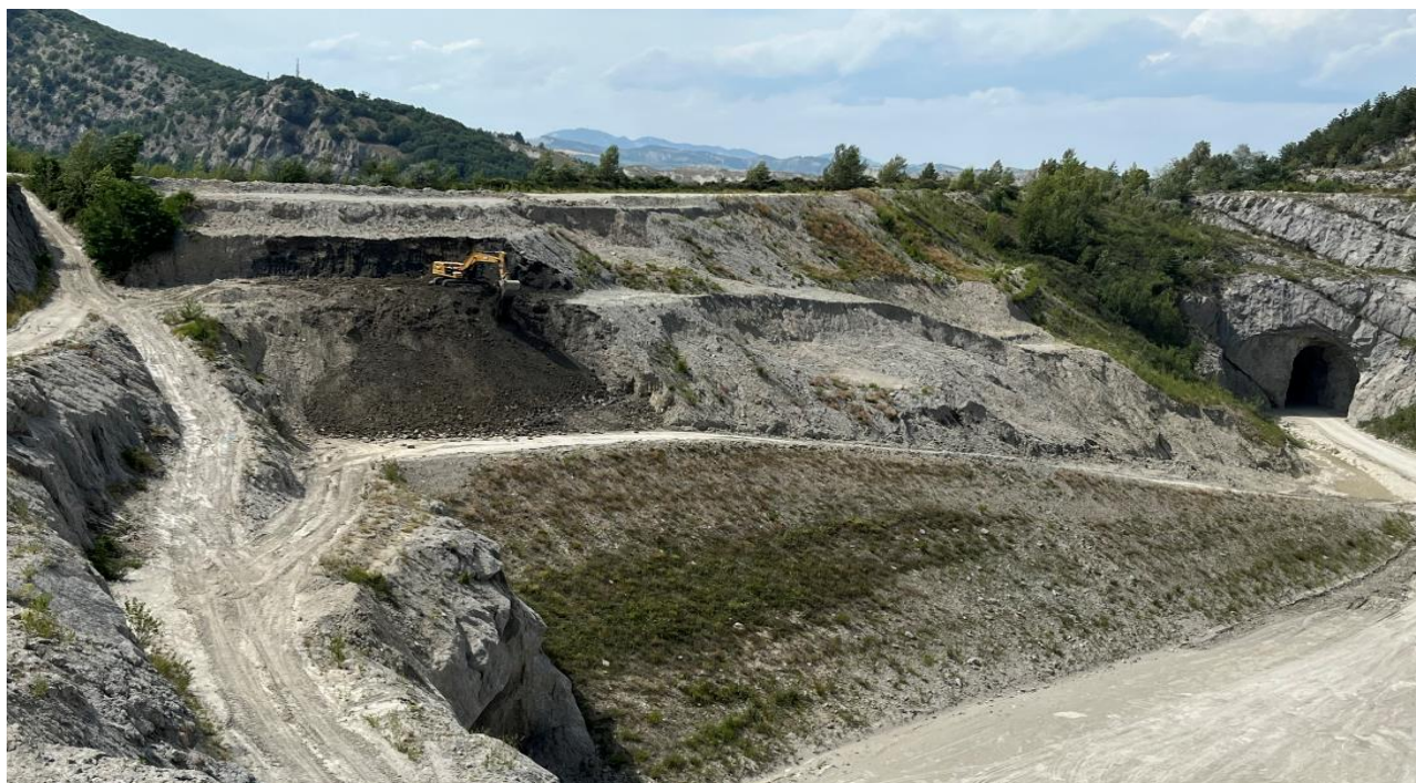
Foto 9: Il cumulo principale, attività di rimodellamento morfologico con escavatore cingolato.
