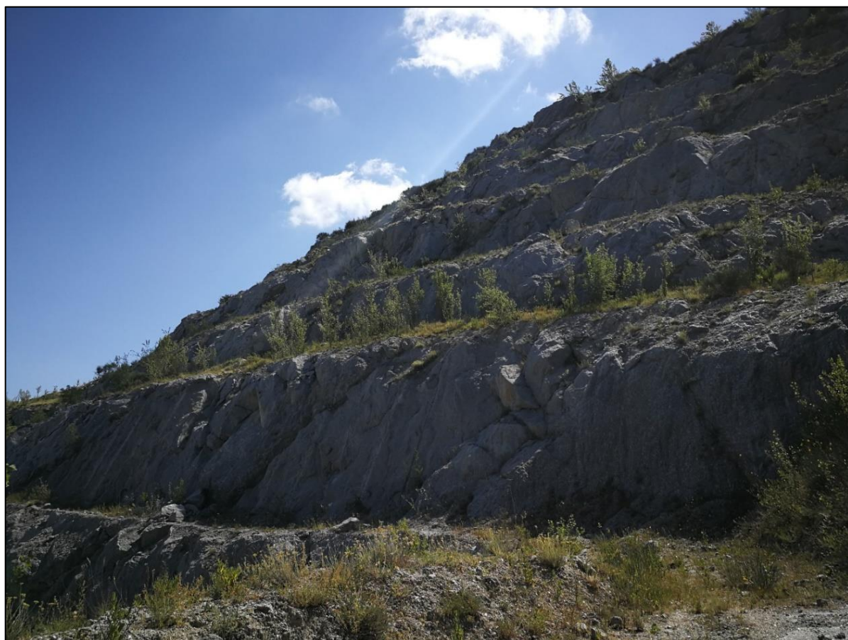
Foto 8: Particolare gradoni ripristinati oltre quota 350 m.
