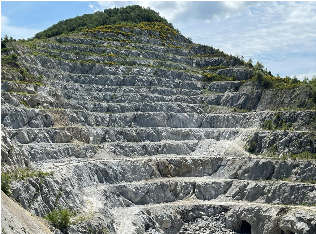
Foto 5: Vista frontale da quota 280 m con dettaglio gradonatura.
