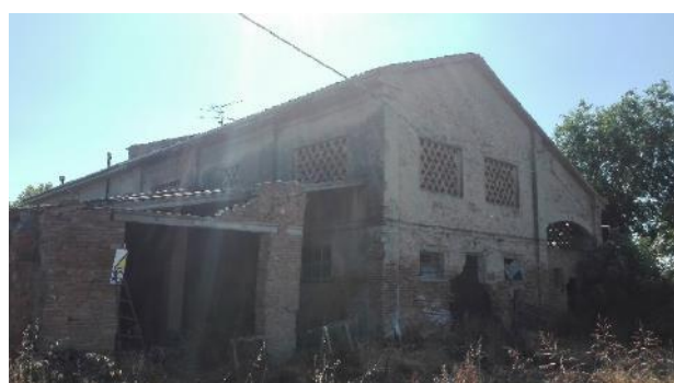
Fig. 2.21.5 - Vista fronte sud (portico con copertura in amianto) e fronte nord della stalla fienile
