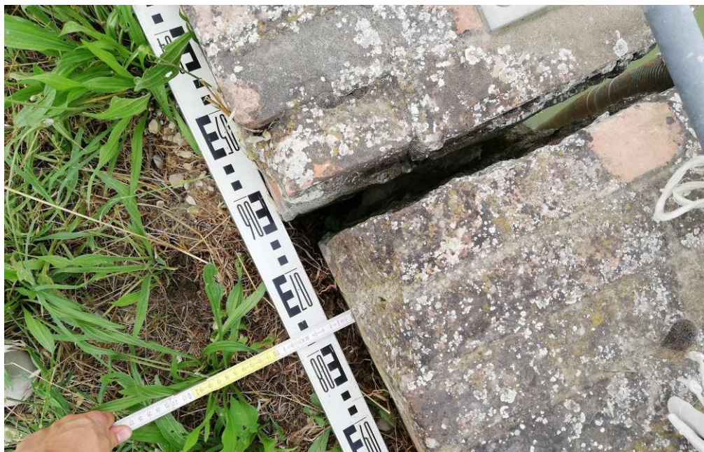
Foto n° 5 – rilievo del disallineamento timpano nord in corrispondenza della fessura
