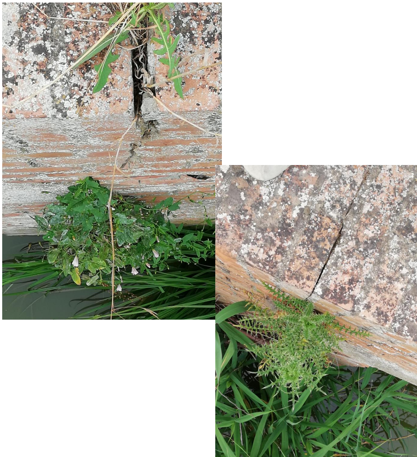
Foto n° 10 – lesione timpano sud - spalla est (dettaglio)
