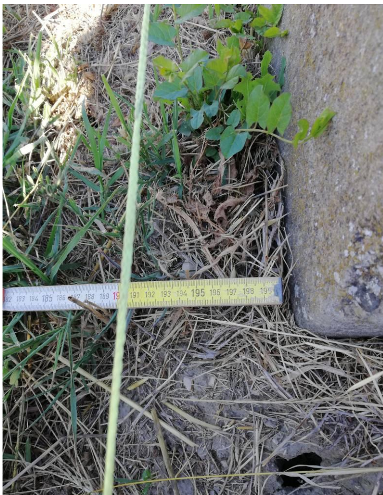
Foto n° 4 – rilievo del disallineamento estremità timpano nord
