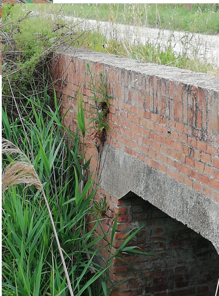
Foto n° 9 – lesione timpano sud – spalla ovest
