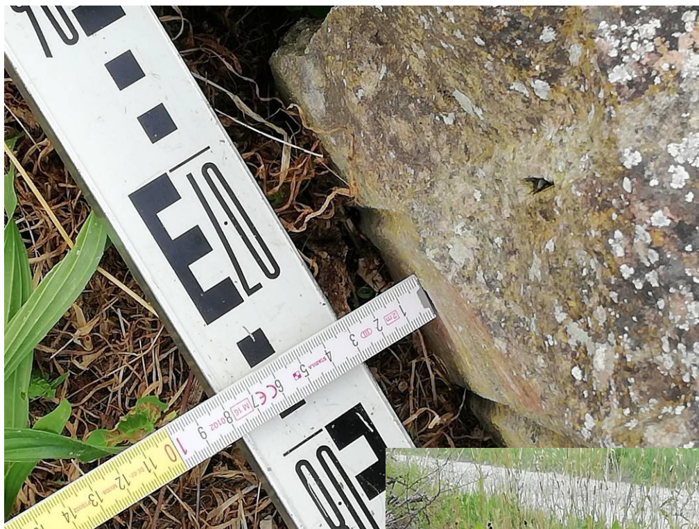
Foto n° 6 – rilievo del disallineamento timpano nord in corrispondenza della fessura (dettaglio)
