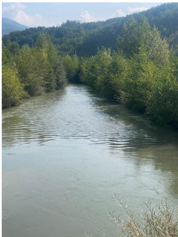
Figura 2 – Canale di adduzione in terra della centrale di Bardi nel tratto iniziale (a sinistra) e nel tratto finale in ingresso alla vasca di carico con sfioro laterale (a destra)
