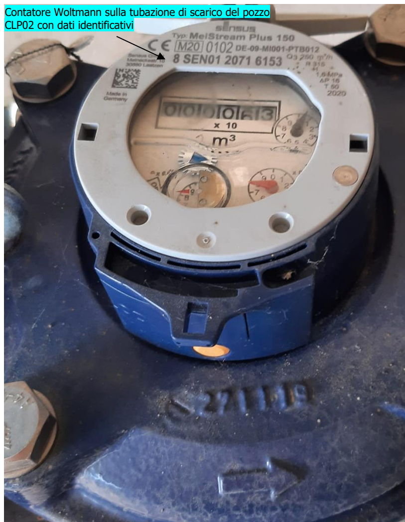
Foto 30 – Contatore Woltmann con dati identificativi e specifiche tecniche sulla tubazione di scarico del pozzo CLP02.
