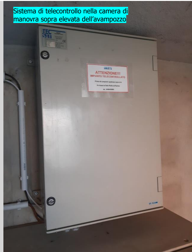
Foto 40 e 41 – Testata del pozzo con punto di rilievo manuale della falda e rubinetto di prelievo in avampozzo e sistema di telecontrollo nella parte sopra elevata dell'avampozzo stesso.
