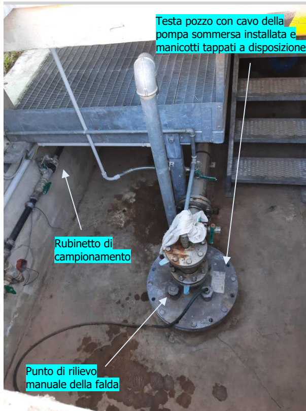
Foto 40 e 41 – Testata del pozzo con punto di rilievo manuale della falda e rubinetto di prelievo in avampozzo e sistema di telecontrollo nella parte sopra elevata dell'avampozzo stesso.
