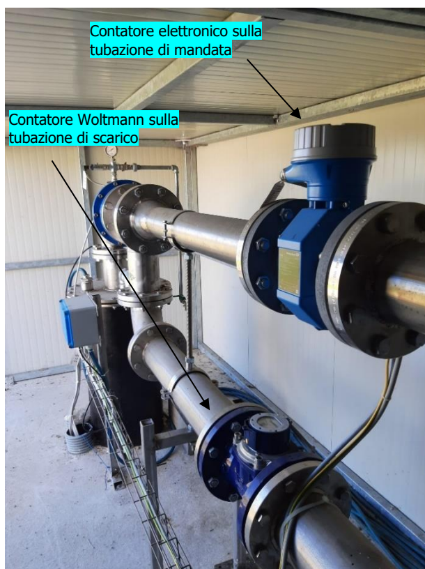
Foto 17 e 18 – Testata del pozzo con i relativi contatori di misura sulla tubazione di mandata verso la rete e la tubazione di mandata in scarico e punto in cui è installata la sonda di livello idrostatica all'interno del pozzo.
