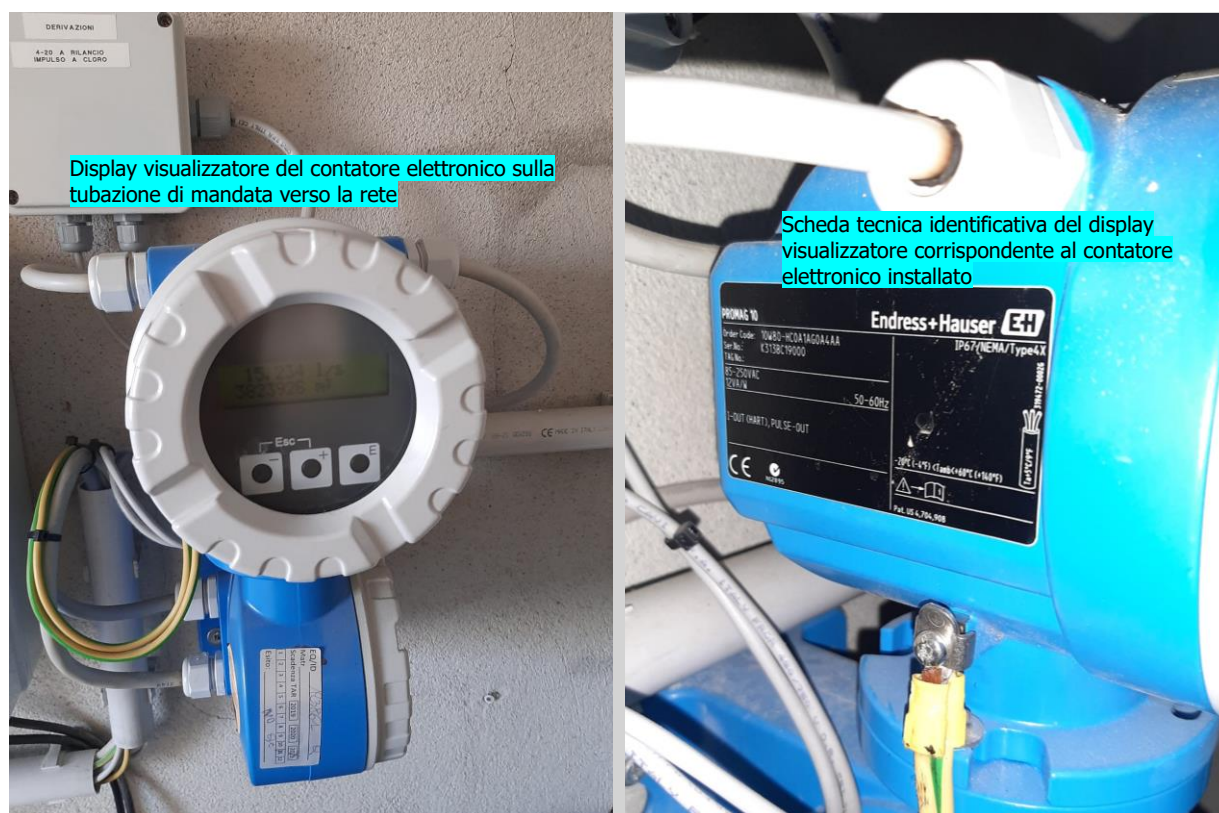
Foto 44 e 45 – Display visualizzatore del contatore elettronico sulla tubazione di mandata in avampozzo verso la rete e scheda tecnica identificativa del visualizzatore corrispondente al contatore stesso installato.
