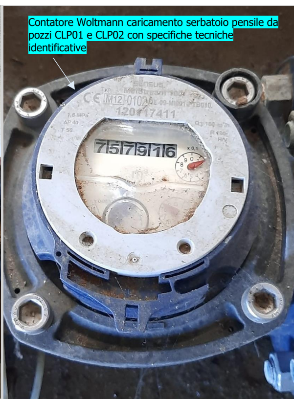
Foto 4 e 5 – Contatori elettronici sull'uscita dal serbatoio pensile per le reti di Calendasco e zona industriale e contatore elettromagnetico non telecontrollato sul caricamento del serbatoio pensile in arrivo dai pozzi CLP01 e CLP02.
