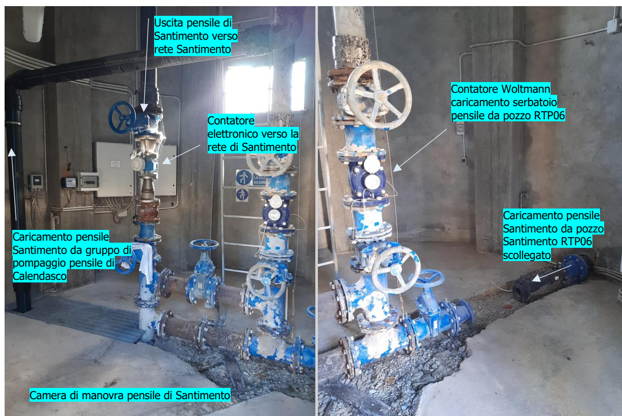
Foto 13 e 14 – Camera di manovra pensile di Santimento con caricamento da gruppo di pompaggio pensile di Calendasco, uscita verso la rete di Santimento e caricamento in arrivo dal pozzo Santimento-RTP06 scollegato.
