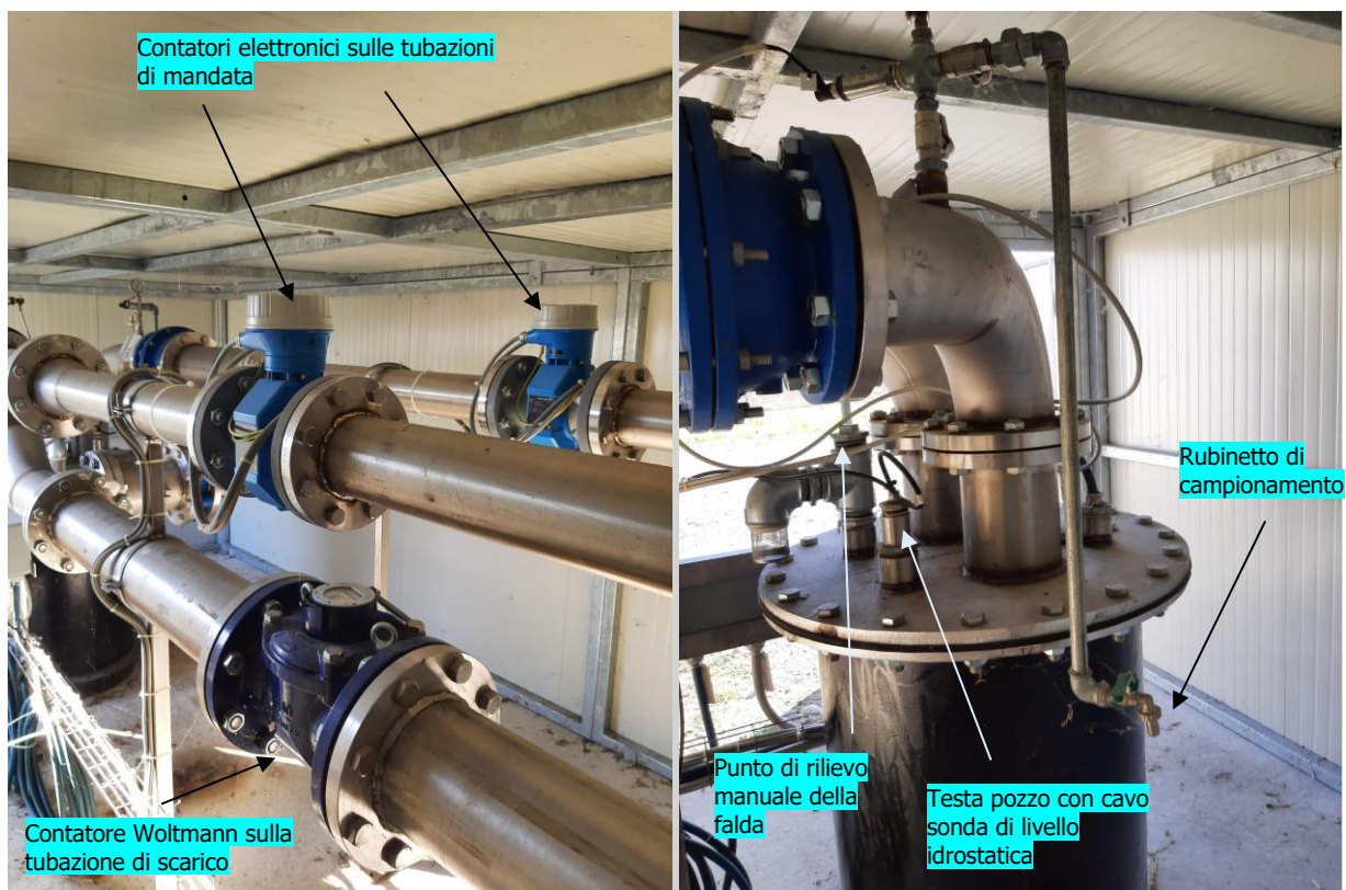
Foto 24 e 25 – Testata del pozzo con i relativi contatori di misura sulle tubazioni di mandata verso la rete e la tubazione di mandata in scarico e punto in cui è installata la sonda di livello idrostatica all'interno del pozzo, del rubinetto di campionamento e del punto in cui si rileva la falda manualmente con il freatimetro.
