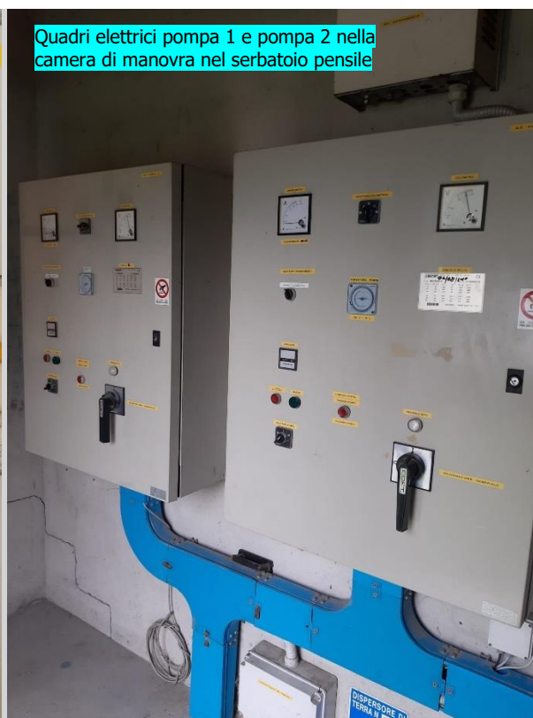
Display visualizzatore del contatore elettronico sul caricamento del serbatoio pensile (pompa 1 e pompa 2)
