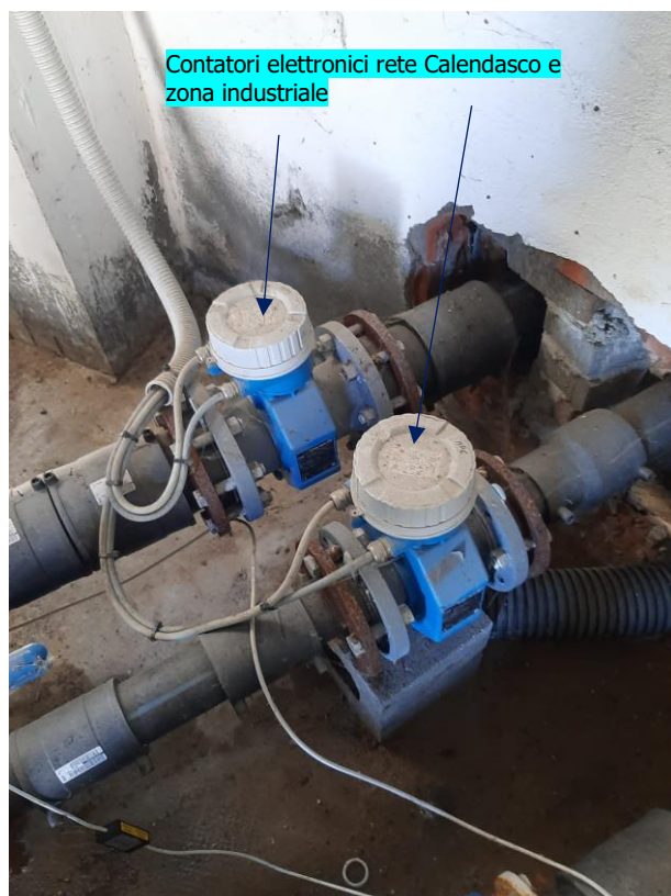
Foto 4 e 5 – Contatori elettronici sull'uscita dal serbatoio pensile per le reti di Calendasco e zona industriale e contatore elettromagnetico non telecontrollato sul caricamento del serbatoio pensile in arrivo dai pozzi CLP01 e CLP02.
