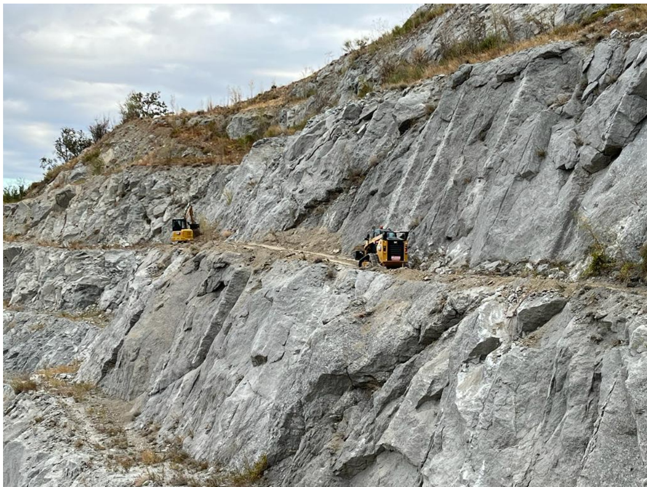
Foto 1 - Operazioni di recupero dei gradoni esauriti (primavera 2023)
