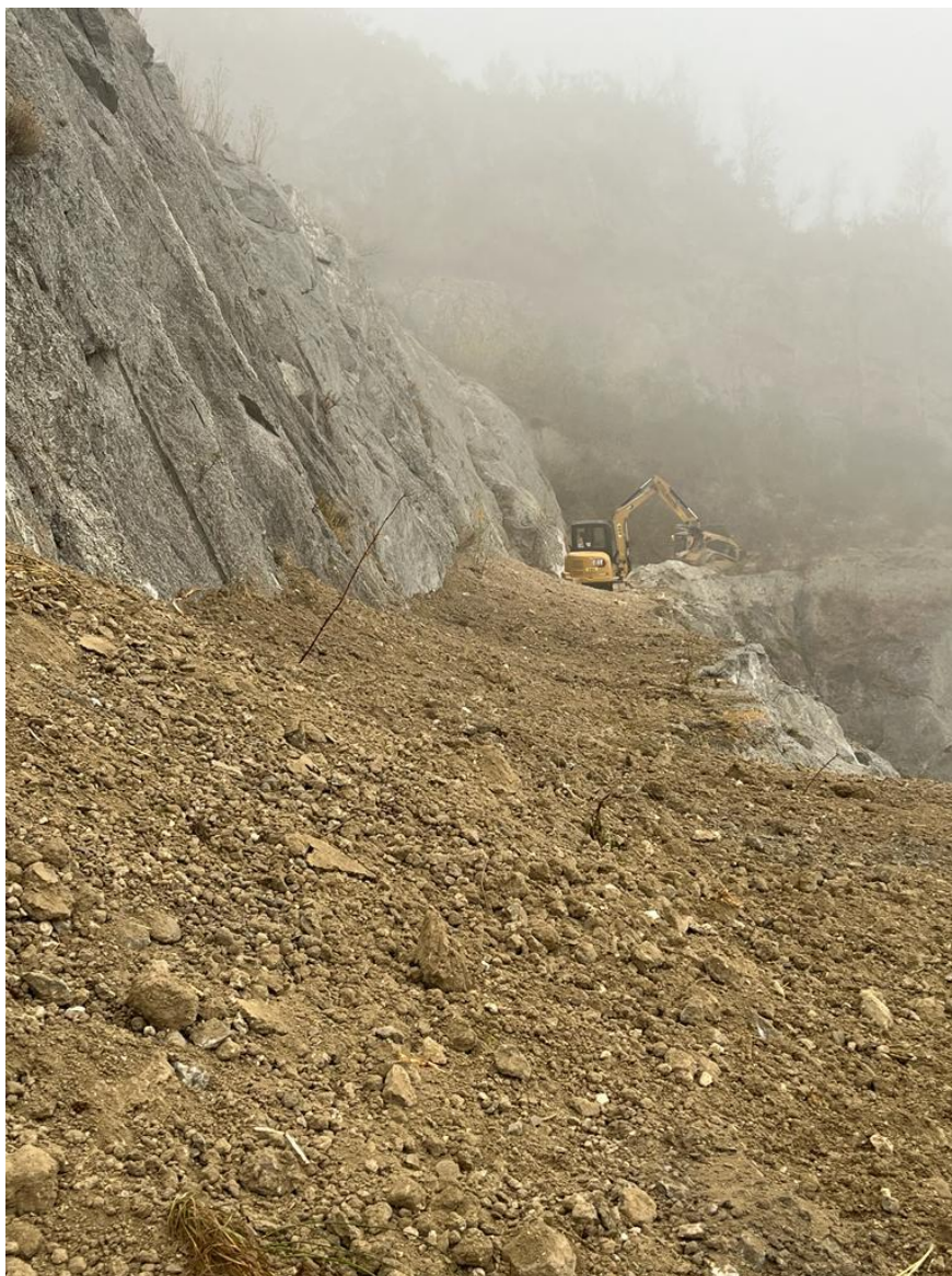
Foto 2 - Stendimento del terreno vegetale sui gradoni
