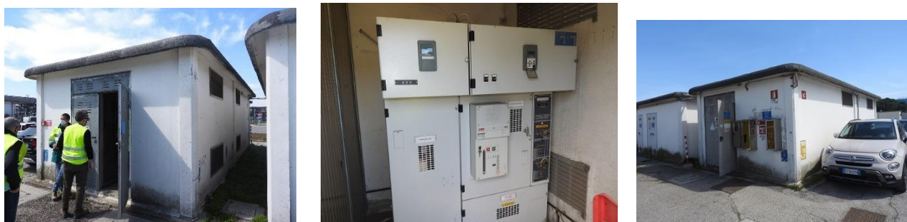
Figure 2-3-4: 1) Ingresso Cabina Cessione e Cabina Riserva; 2) Quadro MT Generale dentro cabina di cessione; 3) Ingresso Cabina Area
