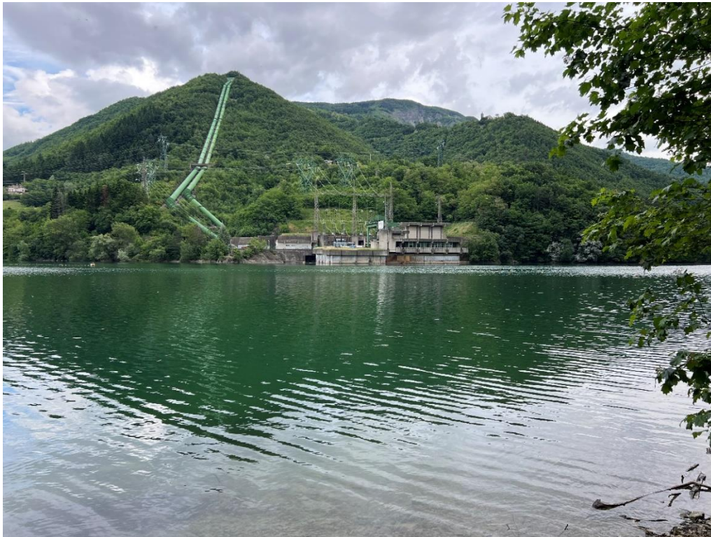
Figura 4.2.1 – Punto di vista “spiaggetta antistante la Centrale idroelettrica di Bargi”: stato di fatto
