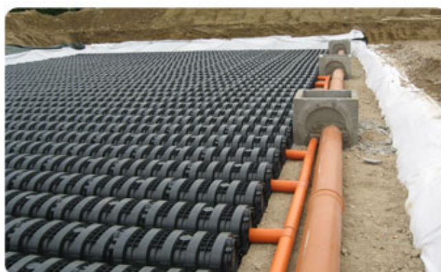
Figura 29 – Vista modalità di posa di elementi modulari in HDPE a tunnel.
