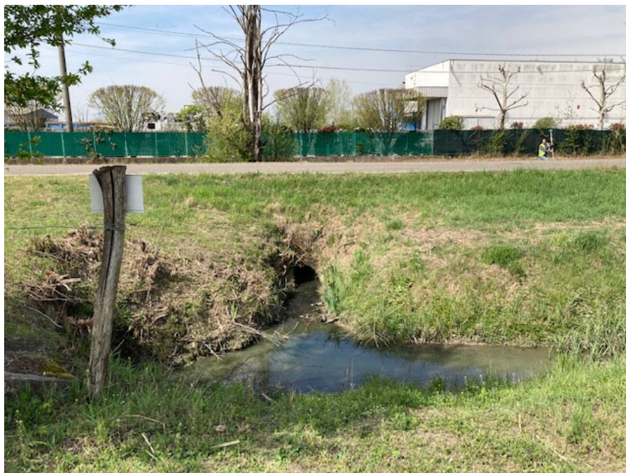
Fotografia 3 – Vista dello sbocco del manufatto di attraversamento stradale del rio Remesina di collegamento alla Fossetta Gruppo.
