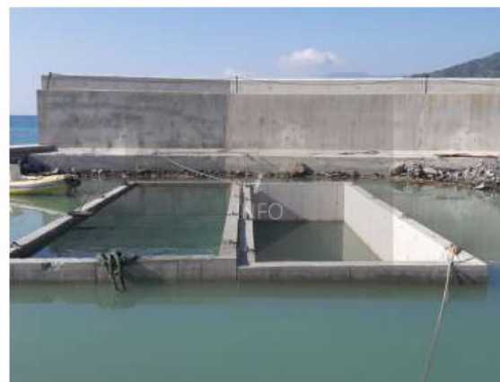
Figura 17 – Vasche per carburanti di calcestruzzo in opera con additivo Penetron posate nel mare nel porto di Ventimiglia (IM).
