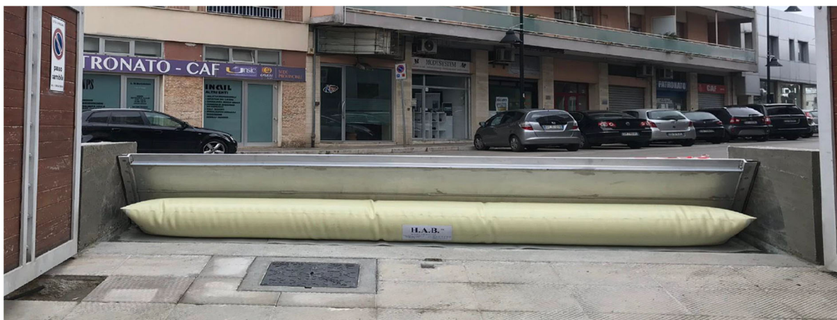
Figura 25 - Esempio di barriera anti-allagamento mobile ad aria, realizzata in prossimità di un accesso carrale.
