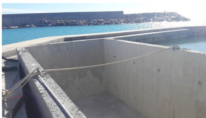
Figura 17 – Vasche per carburanti di calcestruzzo in opera con additivo Penetron posate nel mare nel porto di Ventimiglia (IM).
