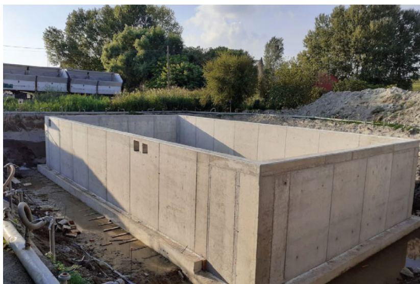
Figura 27 – Esempio di vasca interrata in c.a. in opera.
