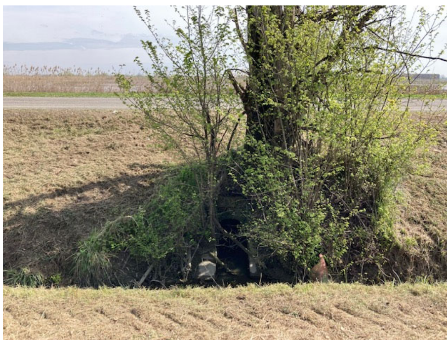
Fotografia 2 – Vista dell'imbocco del manufatto di attraversamento stradale del rio Remesina di collegamento alla Fossetta Gruppo.
