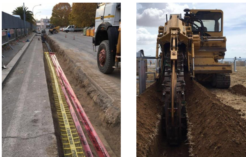
Figura 22: Esempio di realizzazione di cavidotto interrato su strada asfaltata e terreno vegetale
