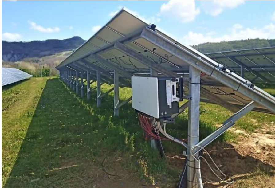
Figura 20: Esempio di cablaggio inverter di stringa
