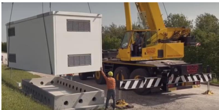
Figura 23: Fornitura e posa in opera delle cabine di campo e dei locali tecnici
