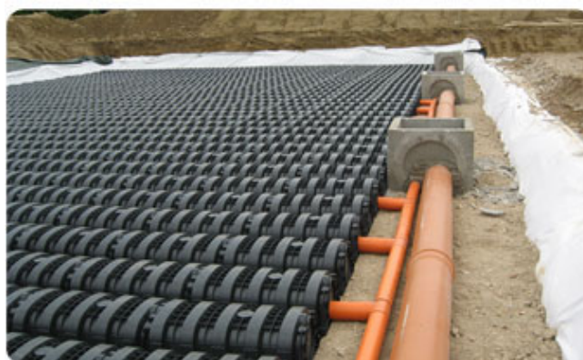
Figura 12 – Vista modalità di posa di elementi modulari in HDPE a tunnel.
