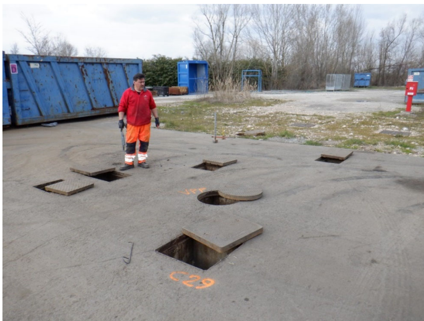
Fotografia 5 – Vista del piazzale dove sono state installate le vasche di prima pioggia, asservite alla rete fognaria meteorica piazzali dell'impianto.
