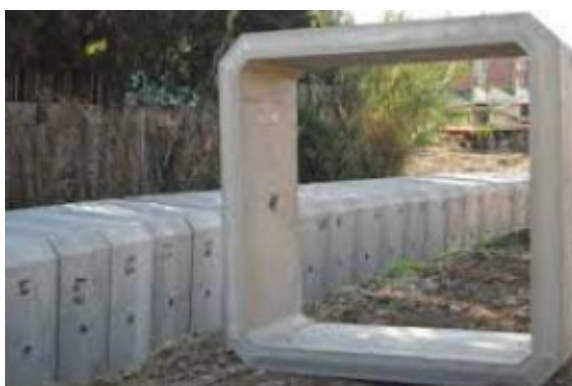
Figura 13 – Esempio di collettore di grandi dimensioni realizzato con scatolari pref. in c.a..
