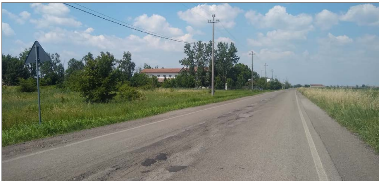
Fig. 44 – Dettaglio dello stato attuale del manto stradale di Via Remesina Esterna
