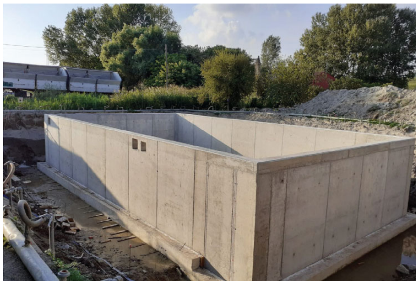
Figura 14 – Esempio di vasca interrata in c.a. in opera.
