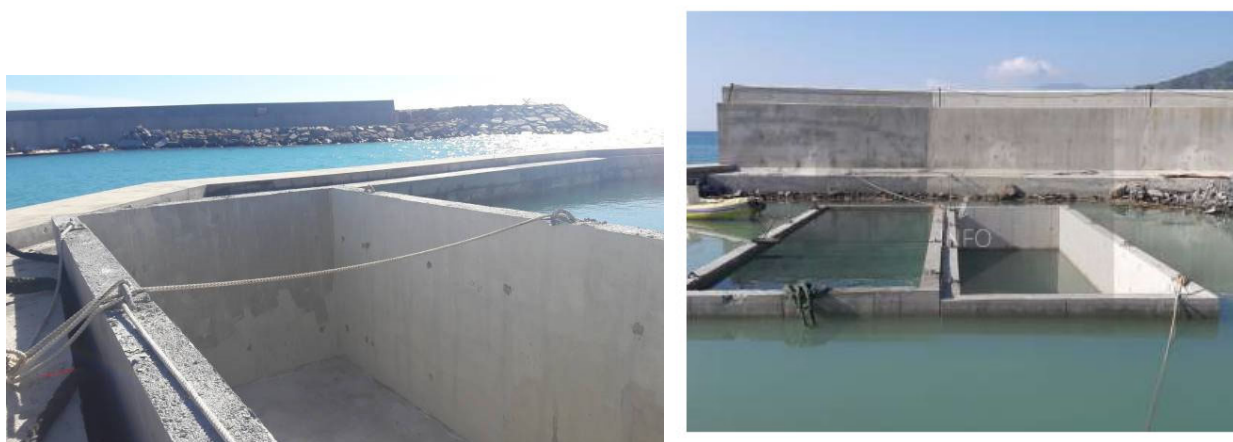
Figura 17 – Vasche per carburanti di calcestruzzo in opera con additivo Penetron posate nel mare nel porto di Ventimiglia (IM).
