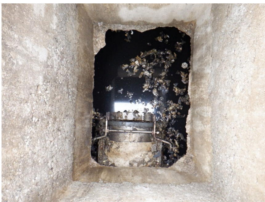
Fotografia 6 – Vista della valvola a galleggiante che regola l'alimentazione dei comparti di invaso delle vasche di prima pioggia asservite alla rete fognaria meteorica piazzali dell'impianto.
