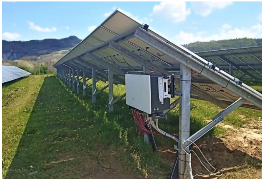
Figura 20: Esempio di cablaggio inverter di stringa
