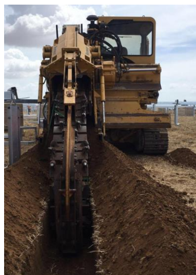
Figura 22: Esempio di realizzazione di cavidotto interrato su strada asfaltata e terreno vegetale
