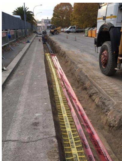
Figura 22: Esempio di realizzazione di cavidotto interrato su strada asfaltata e terreno vegetale
