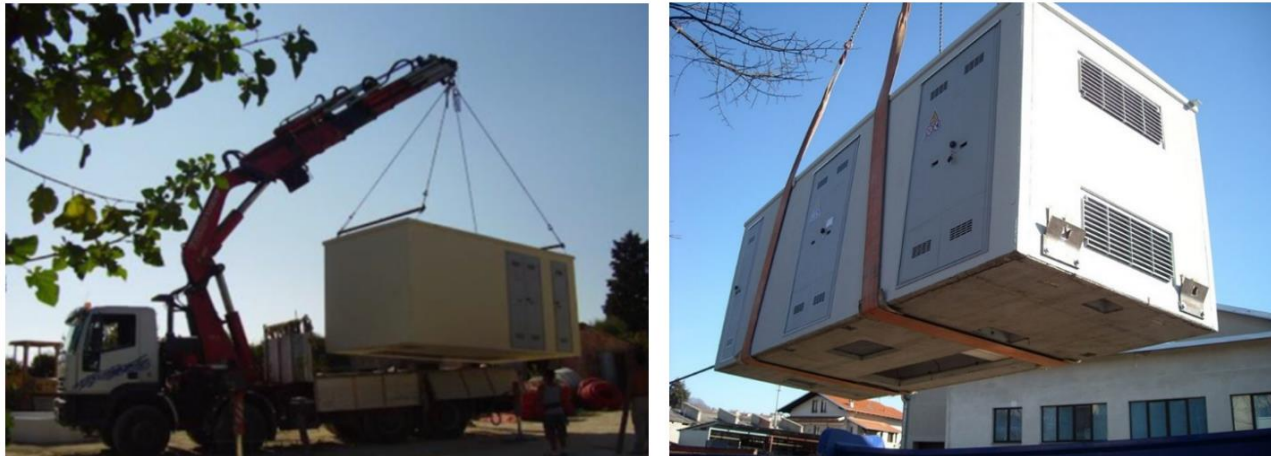
Figura 29: Rimozione delle cabine di raccolta e delle power station
