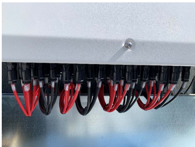
esempio installazione inverter 12 MPPT / 24 ingressi di stringa +/-
