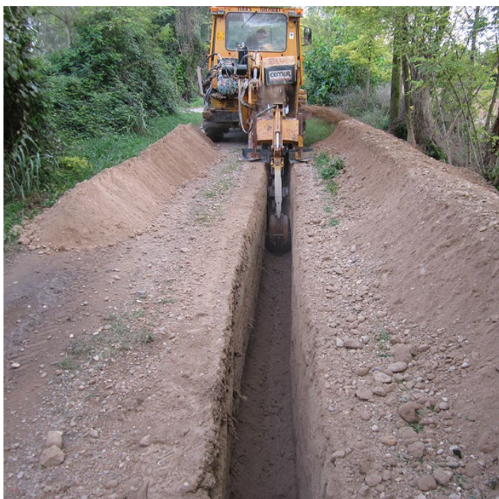
Figura 5 e 6 – Particolari di esecuzione della posa su scavo aperto
