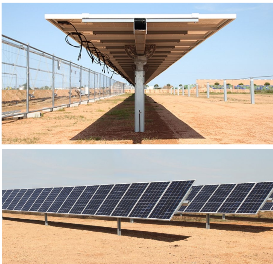
Figura 9 – Esempio tipo strutture porta pannelli
