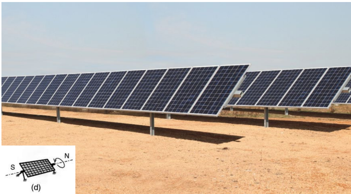
Figura 8 – Esempio struttura pannelli con inseguitori
