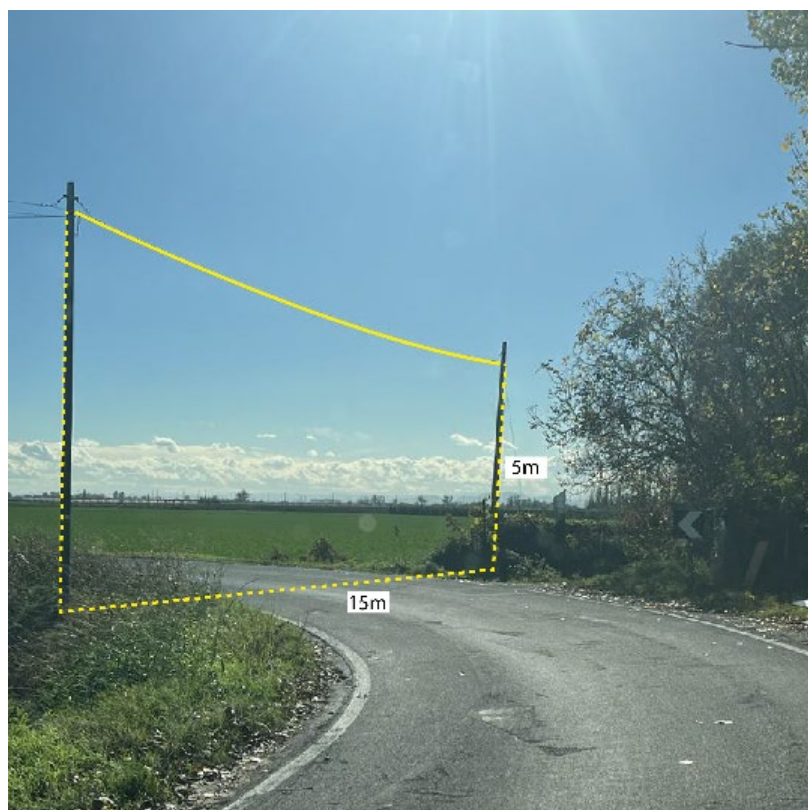
Figura 7 – Dettaglio interferenza cavi linea elettrica in Via Saletto
