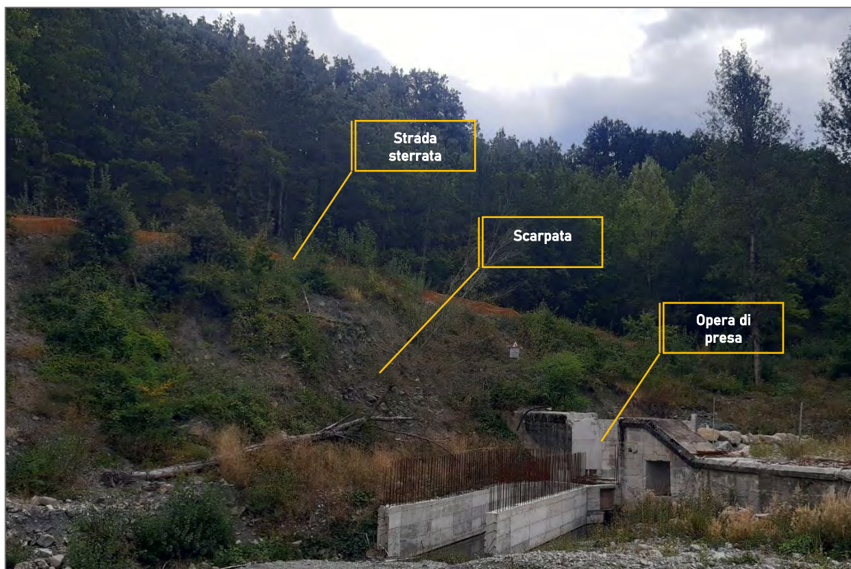
Fig. 4.9: Panoramica del fronte di scavo e sbancamento attuato per la messa in opera delle strutture previste.
