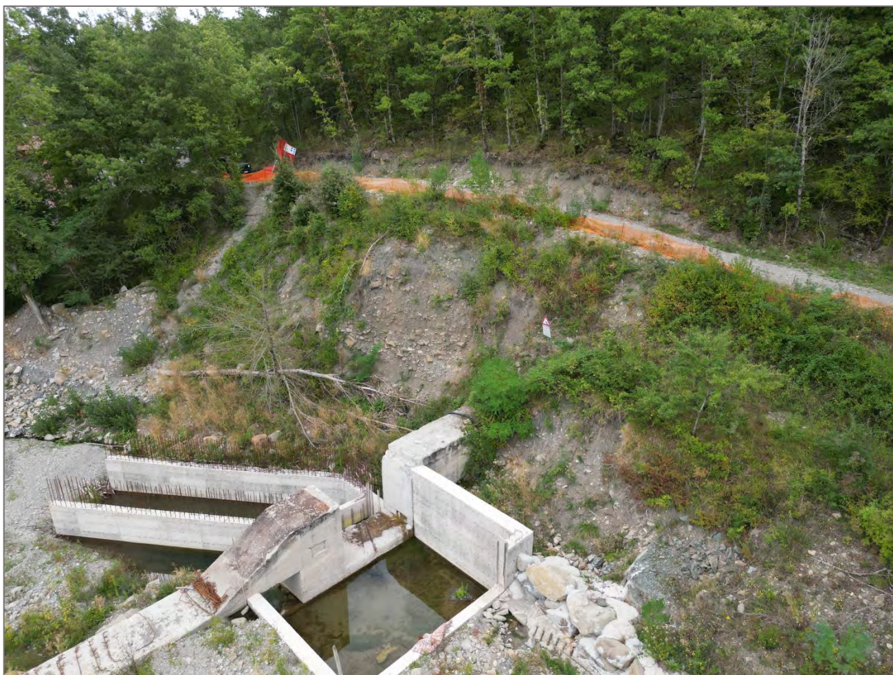
Fig. 4.10: Panoramica del fronte di scavo e sbancamento attuato per la messa in opera delle strutture previste.
