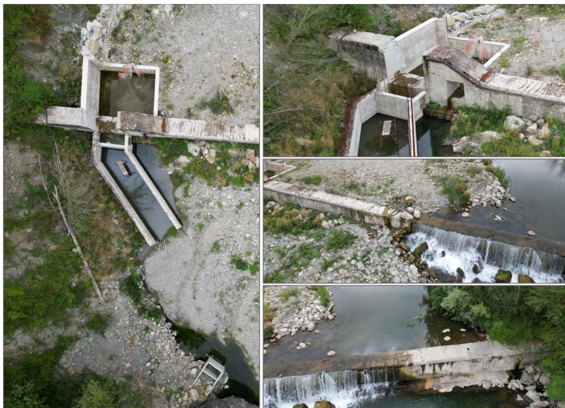
Fig. 4.4: Dettagli da diverse angolazioni della costruzione attualmente messa in opera e della briglia preesistente (settembre 2023).
