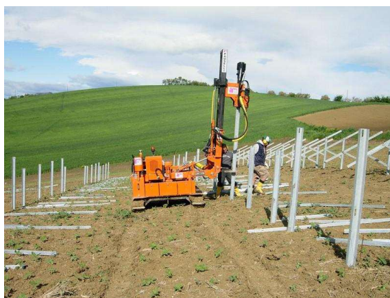
Figura 3: - Posa strutture metalliche di fondazione
