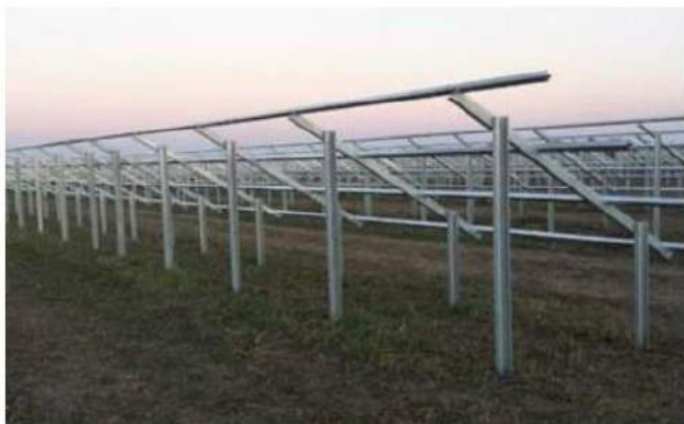
Figura 5-1 – Esempio di posa delle strutture portanti.
