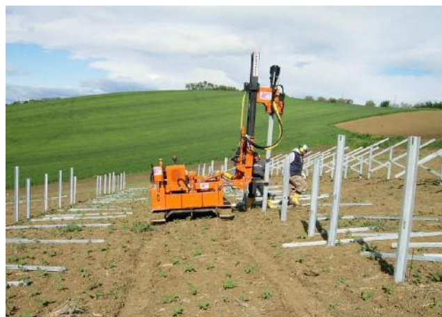
Figura 3-3 – Posa strutture metalliche di fondazione
