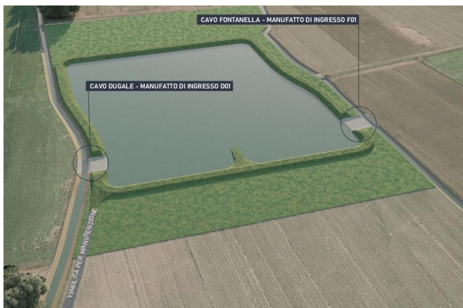
Figura 1 – Foto inserimento vasca di laminazione
