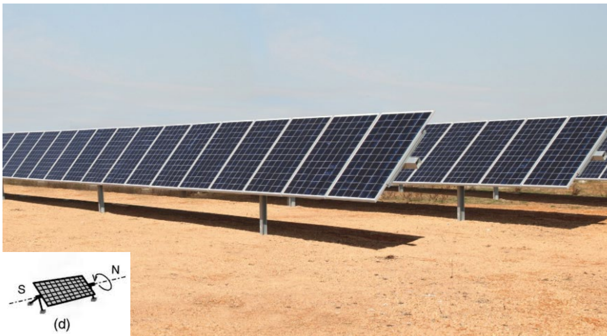
Figura 8 – Esempio struttura pannelli con inseguitori
