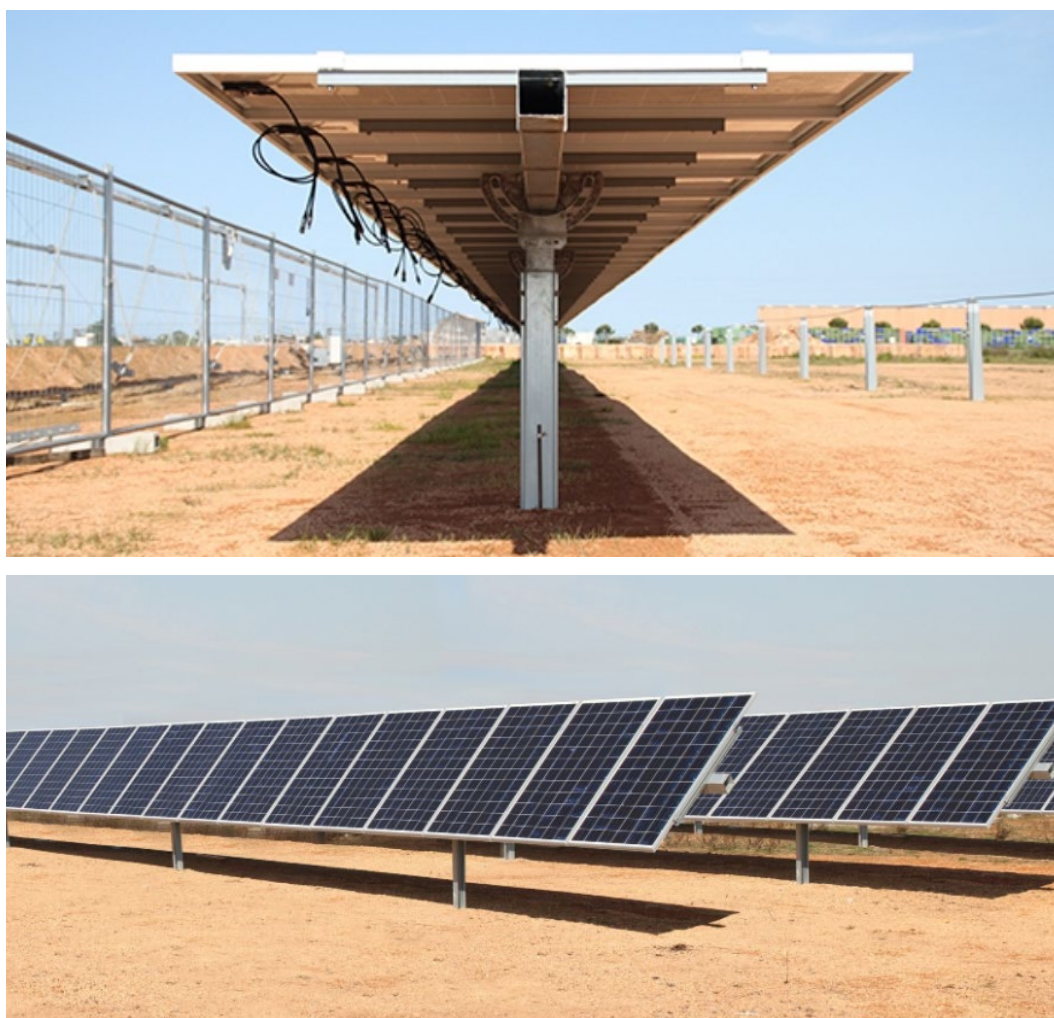
Figura 9 – Esempio tipo strutture porta pannelli
