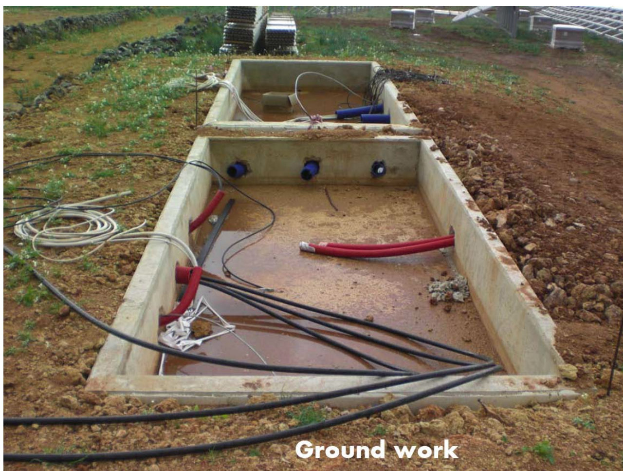
Figura 5 - basamento cabina
