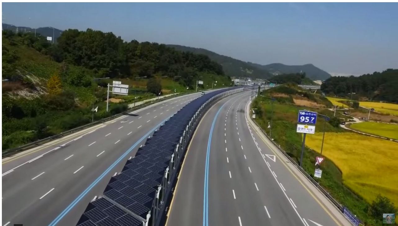
Figura 6 – Pista ciclabile alimentata ad energia solare costruita al centro dell'autostrada che collega Daejeon e Sejong
